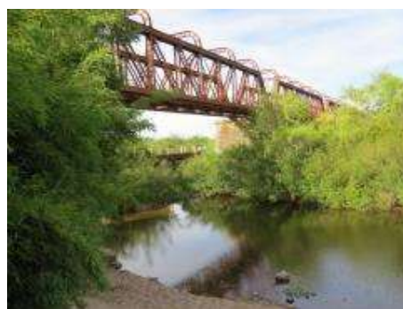
Vista del arroyo desde la cabecera Estribo Sur
