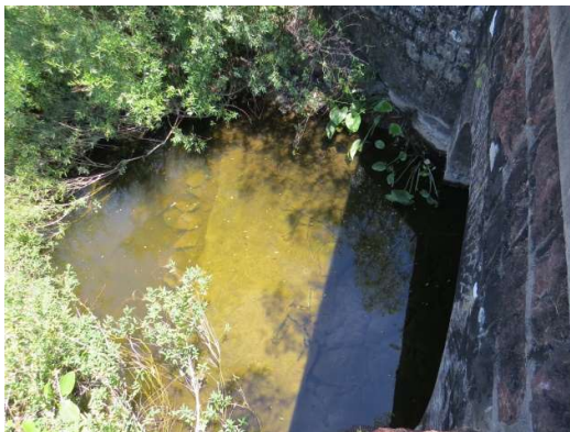
Carpeta de concreto Oeste
