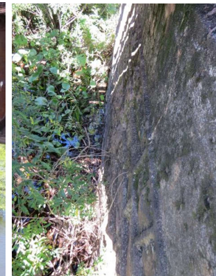
Visto desde Arriba Norte Pilar Central
