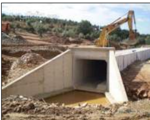
Figura 3-2: Ejemplos de vías de drenaje adaptadas para funcionar como pasajes de fauna.
