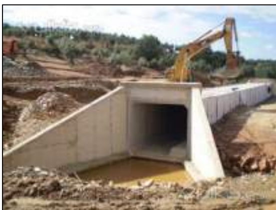
Figura 4-23: Zona de instalación de pasos de fauna y defensas metálicas para controlar la accesibilidad del público.
