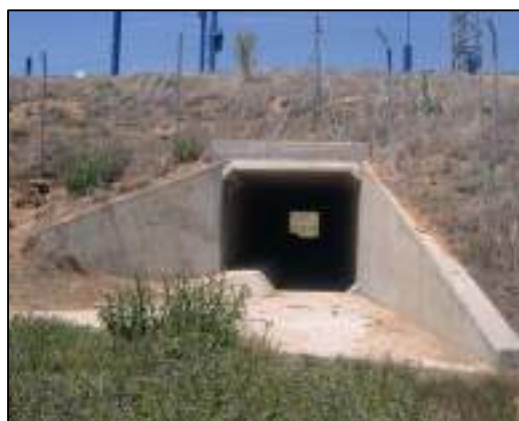
Figura 3-2: Ejemplos de vías de drenaje adaptadas para funcionar como pasajes de fauna.
