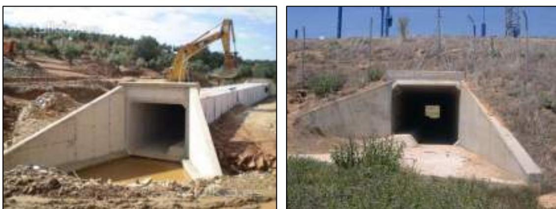
Figura 2-2: Ejemplos de vías de drenaje adaptadas para funcionar como pasajes de fauna.
