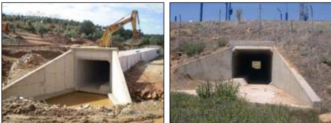
Figura 3-2: Ejemplos de vías de drenaje adaptadas para funcionar como pasajes de fauna.
