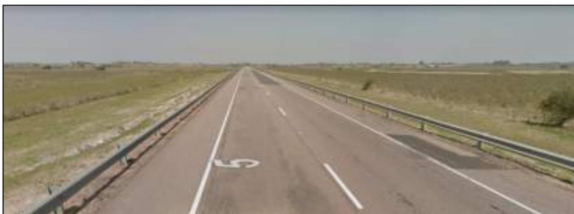
Figura 2-5: Tramo de la ruta N°5, sobre la planicie de inundación del río Santa Lucía, con 1,8 km vallados con defensas metálicas. Imagen extraída de Google Street View.
