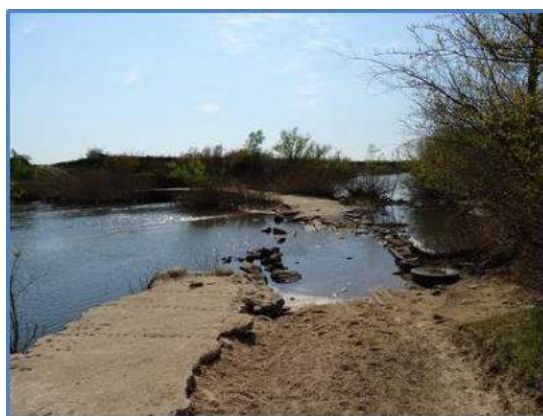
Fig.9 Puente inaccesible para ingresar al Tramo B
