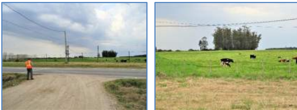
Fig.18 En la primera foto se aprecia el punto sur de conexión del By Pass con la Ruta 6, en coincidencia con la conexión del camino vecinal que conecta Ruta 6 con la Ruta 63. En la segunda foto se ve el monte de eucaliptus, última inflexión por donde pasa el By Pass y se dirige en forma rectilínea hasta Ruta 6.
