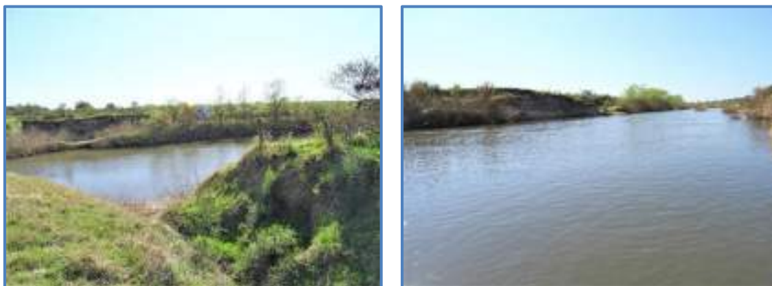
Fig.14 Tramo C, observación de la barranca de la margen norte del A° Pilatos
