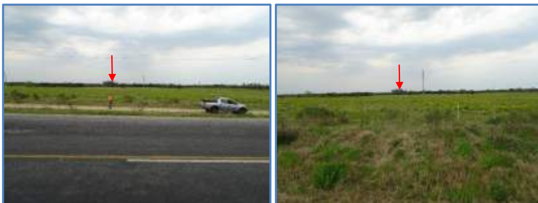
Fig.6 Tramo A1, control visual de 500m del Tramo A1, desde Ruta 6, en primer plano, hasta la flecha roja sobre eucaliptus donde la nueva ruta cruzará el viejo cauce del Río Santa Lucía.
