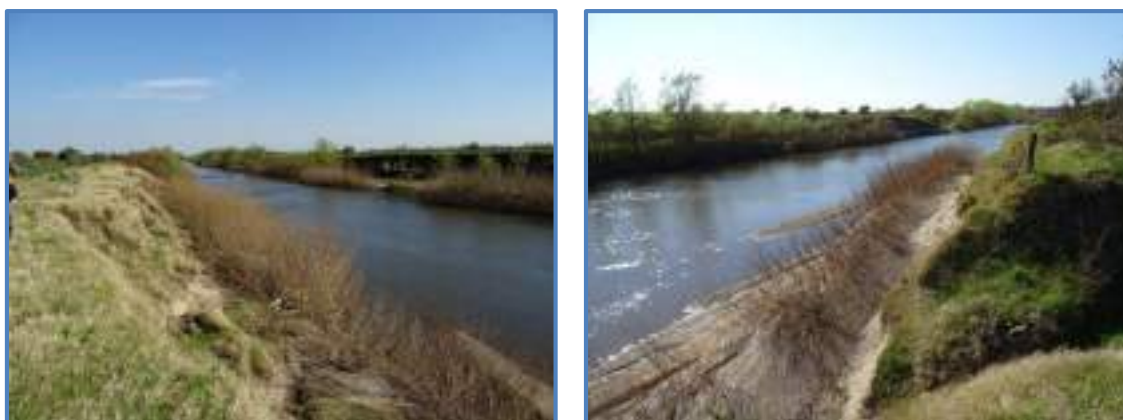
Fig.12 Tramo C, barrancas del A° Pilatos, perspectivas hacia oeste y este
