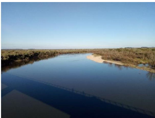
Río Negro – puente 329
