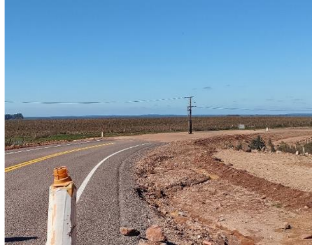
Figura 4 Interferencia con servicio eléctrico
