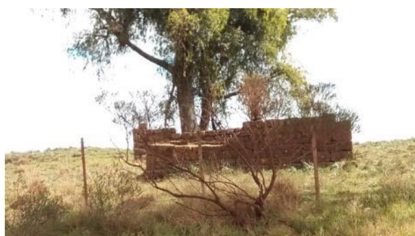
Construcción en piedra seca, departamento de Durazno. Coordenadas -32.98242950; -55.41469572.
