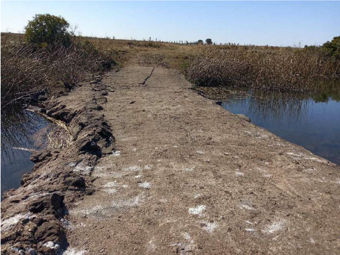
Ilustración 2-11 Actual cruce sobre Arroyo Islas de Arguelle por camino vecinal
