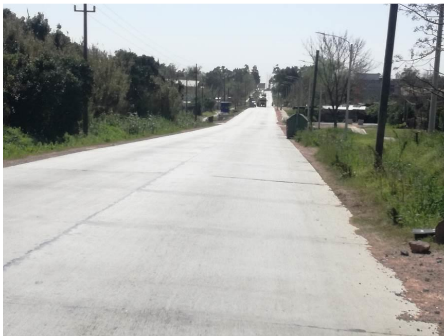
Foto 13.2-1 Vistas de tramo terminado
