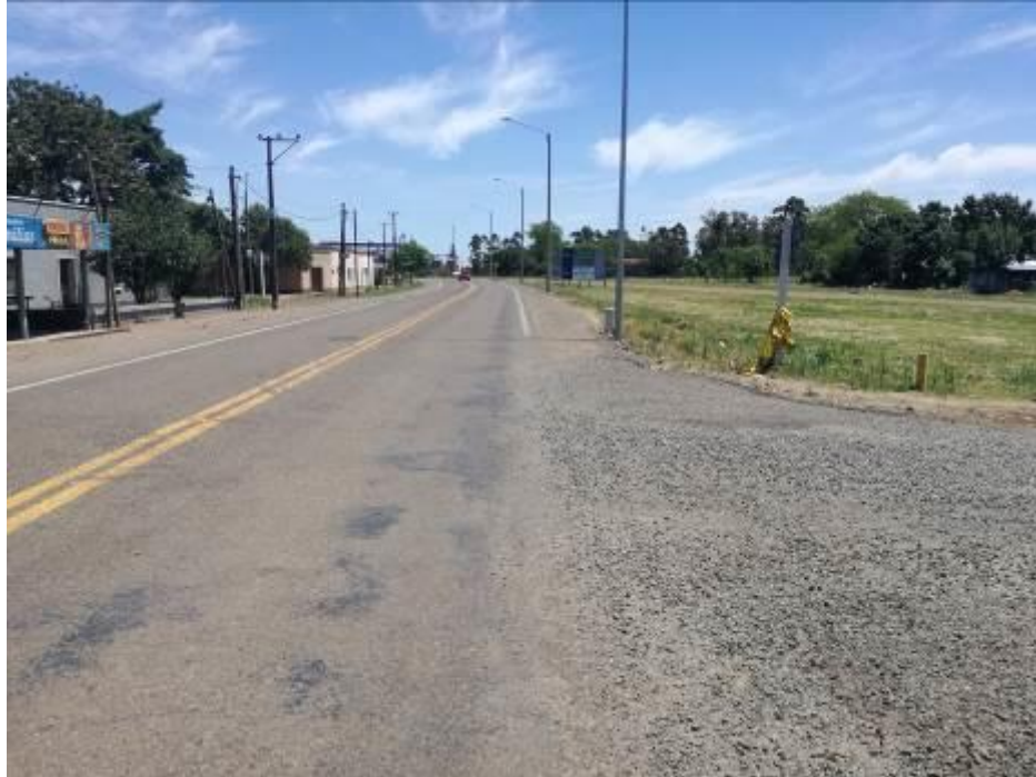
Foto 13.3-1 Vistas tramo terminado.
