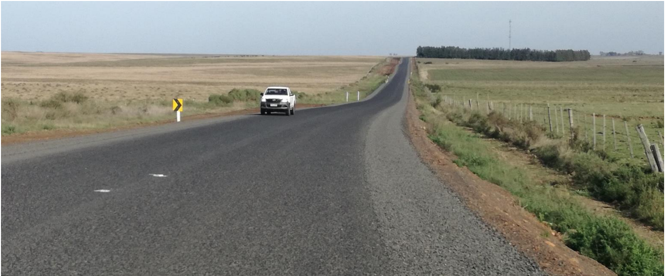
Foto 13.5-1 Vista 3 Tramo terminado en etapa de señalización.
