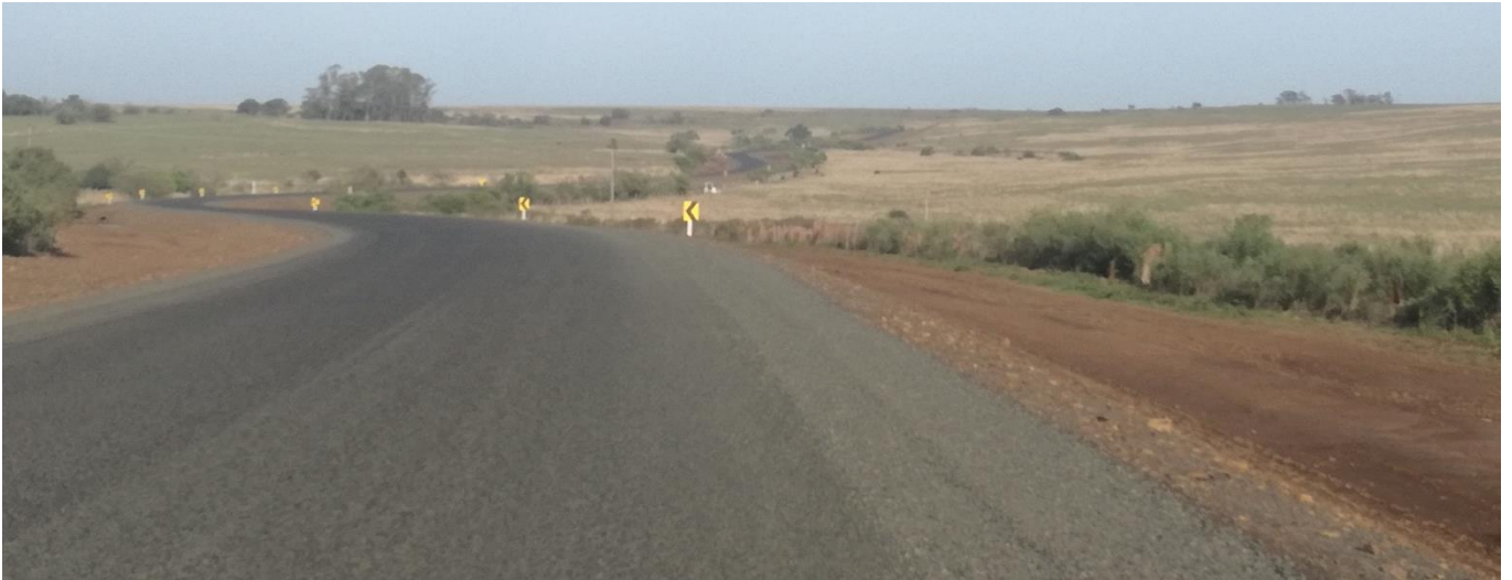
Foto 13.4-1 Vista 1 Tramo terminado en etapa de señalización.
