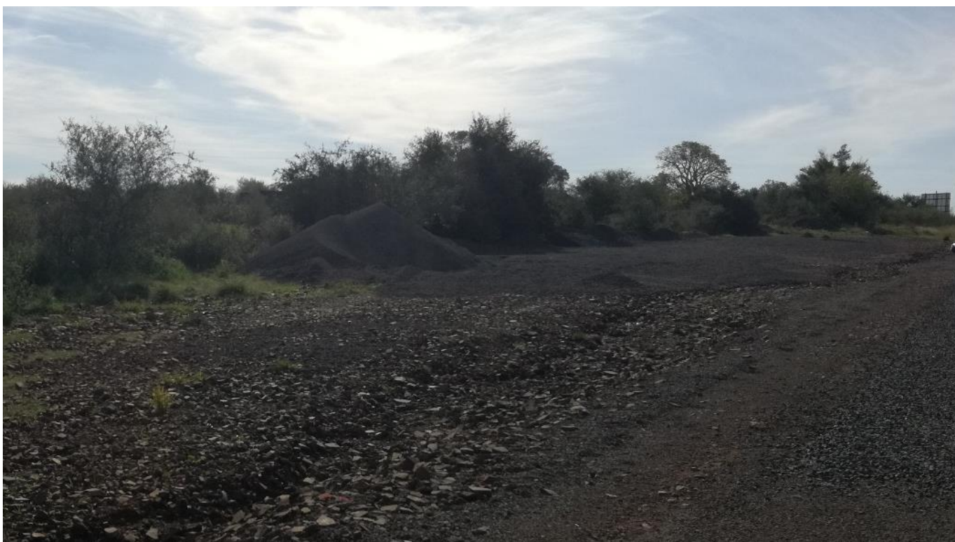
Foto 13.1-1 Vista 6. Acopios en faja
