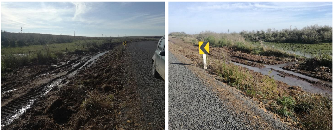
Foto 13.4-2 Vista 2 Tramo terminado en etapa de señalización y regularización de faja.
