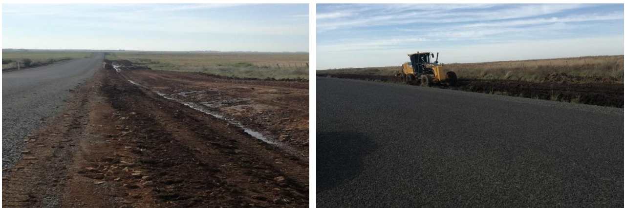
Foto 13.5-2 Vista 4 Tramo terminado en etapa de señalización y regularización de faja.
