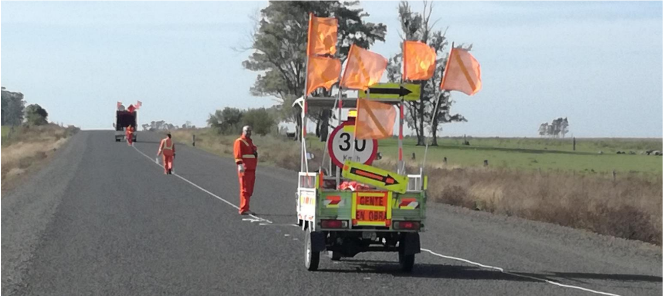
Foto 13.5-3 Vista 5 Frente de Obra señalización Bordonix
