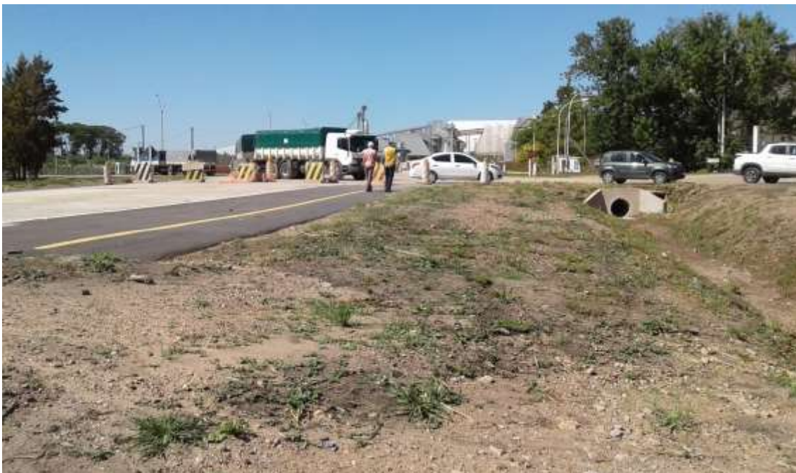
Foto 13.2-1 Vistas By Pass - Tramo Acceso al Puerto
