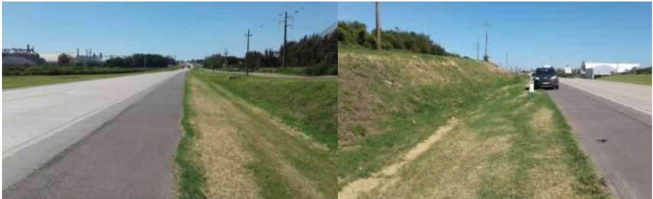
Foto 13.2-2 Vistas By Pass tramo progresivas 0 - 2km000
