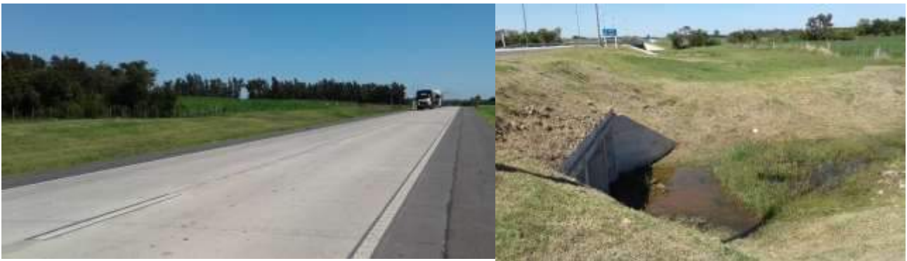
Foto 13.2-4 Vistas By Pass tramo próximo a Ruta 21
