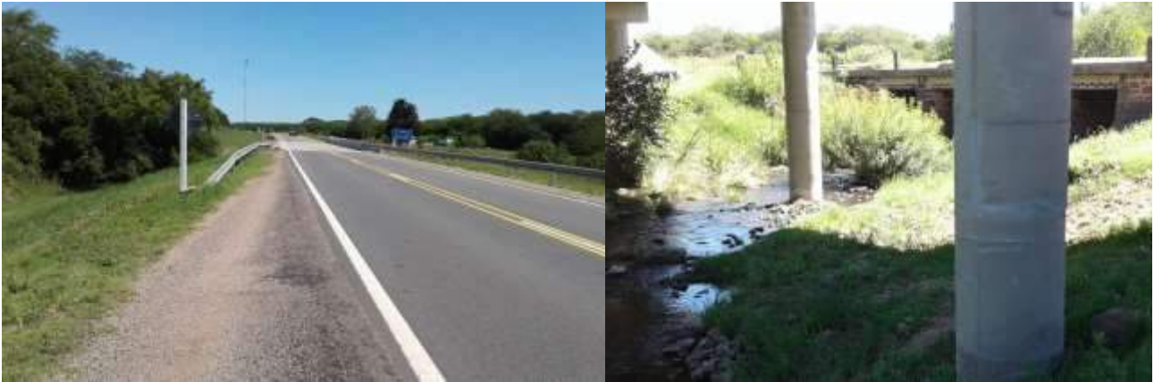
Foto 13.6-1 Vistas Puente Ao. Las Maulas Ruta 21
