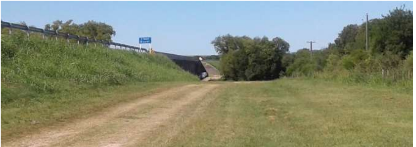
Foto 13.10-1 Vista Puente Ao. Rabón Ruta 24
