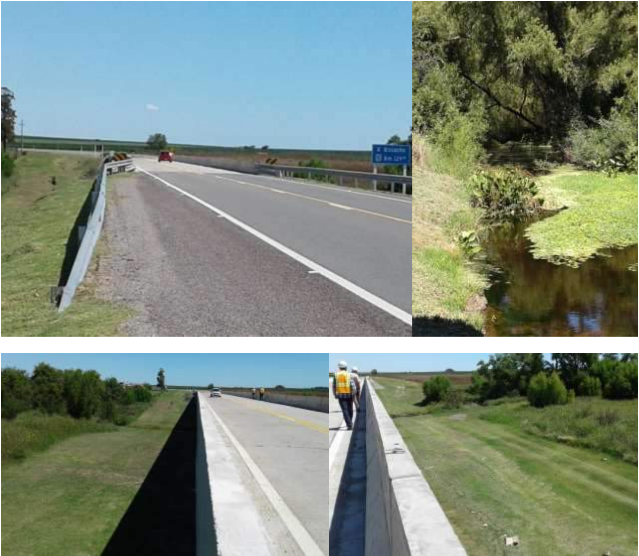
Foto 13.5-1 Vistas Puente Arroyo Bizcocho Ruta 21
