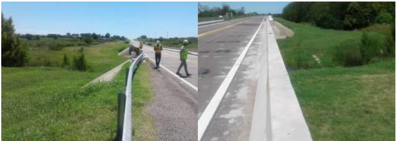
Foto 13.4-1 Vistas Puente Ao. Arenal Chico Ruta 21
