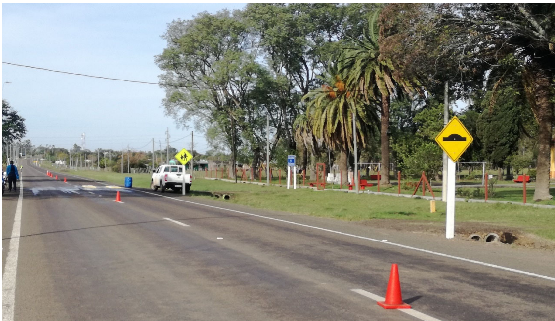
Foto 13.3-1 Vista 1 - Escuela Rural - R 30
