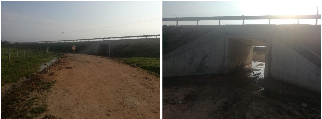
Foto 13.3-1 Vta 1 – Alcantarilla en acceso NE del Puente.
