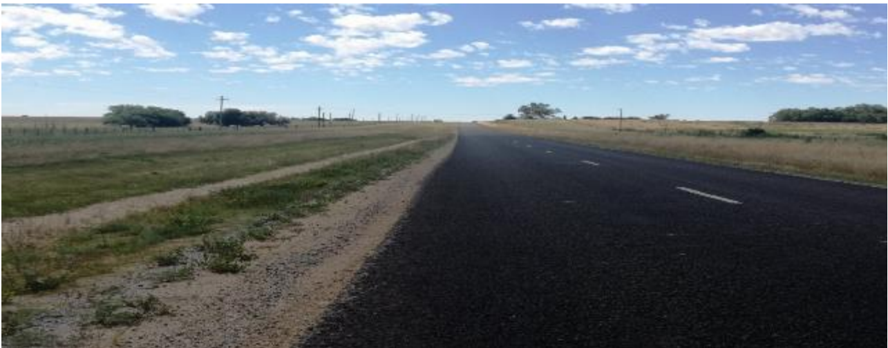
Foto 13.4-1 Recorrido por tramo terminado
