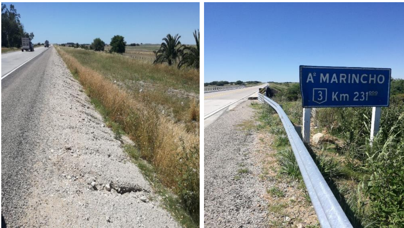
Foto 13.4-1 Recorrido por el tramo del contrato
