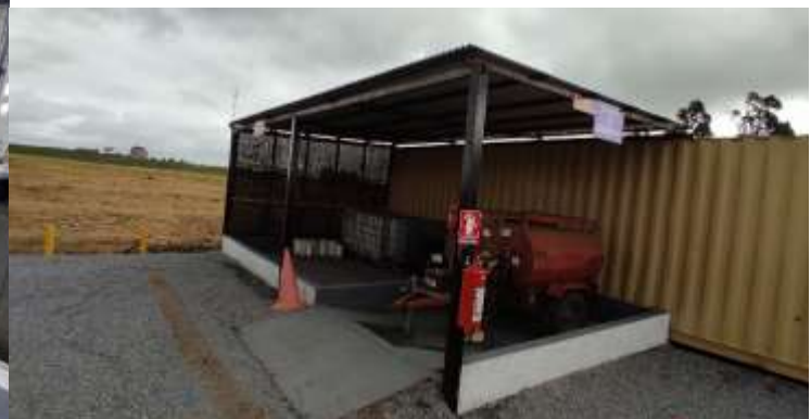
Foto 13.3-1 Vistas obrador SERVIAM
