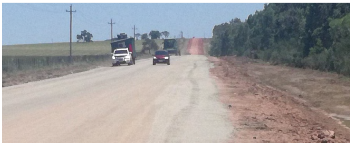
Foto 13.18-2 Vta.8 Frente de Obra CUJÓ
