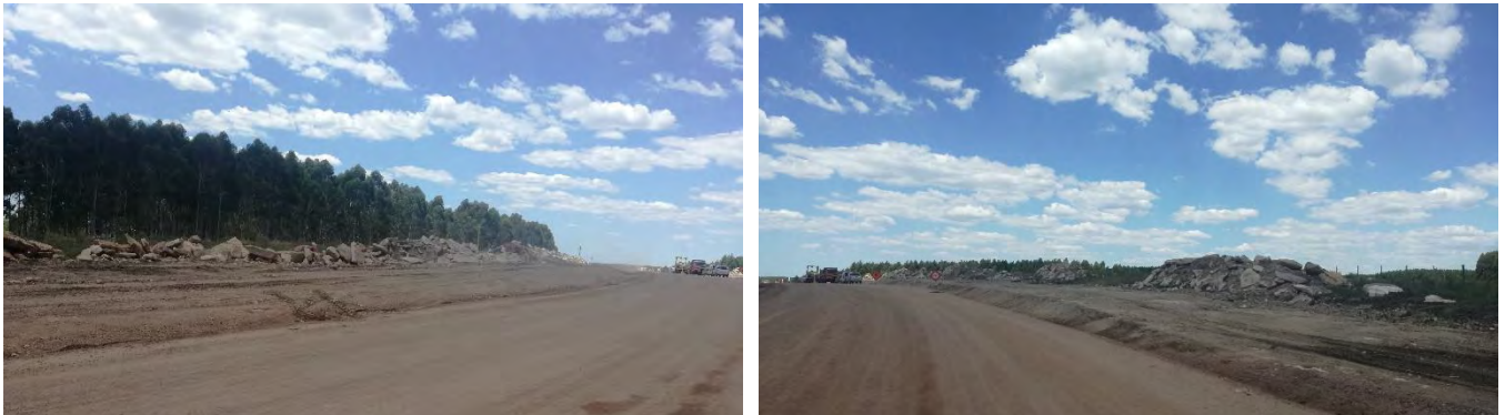
Foto 13.29-1 Vtas. Acopio de piedra en faja.
