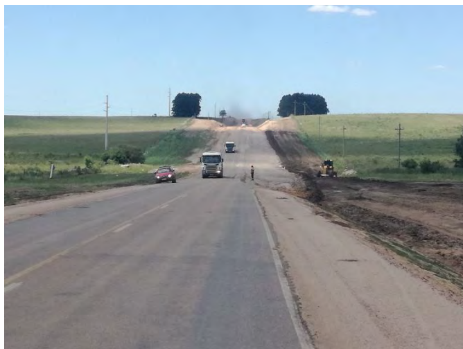
Foto 13.31-2 Vta.17 Frente de Obra CVC
