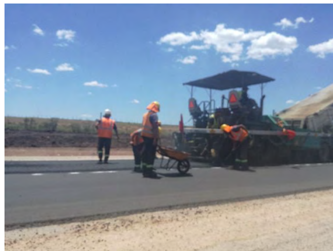
Foto 13.27-2 Vta.13 Frente de Obra Díaz Álvarez
