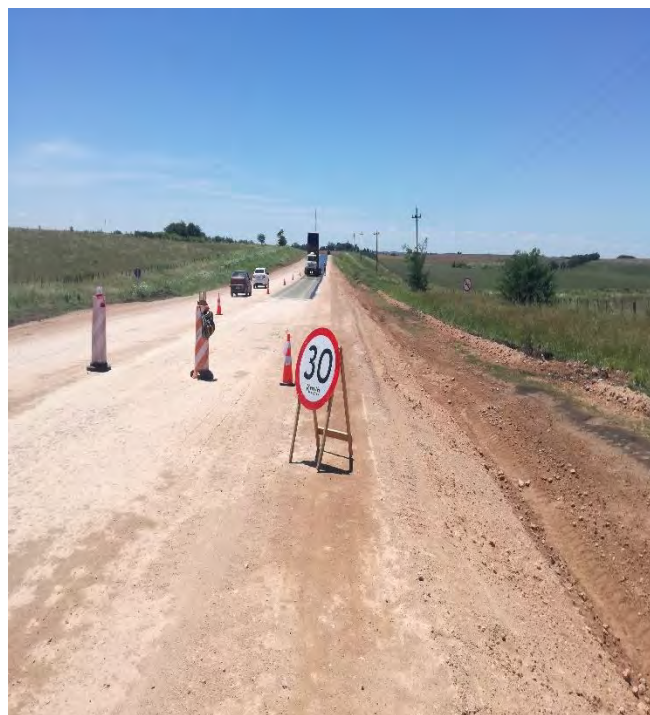
Foto 13.15-1 Vta.4 Frente de Obra CUJÓ
