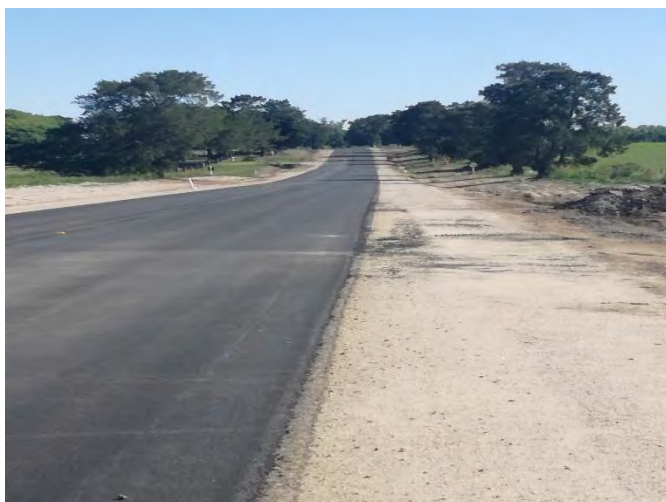
Foto 13.22-1 Vta.10 Tratamiento bituminoso INCOCI
