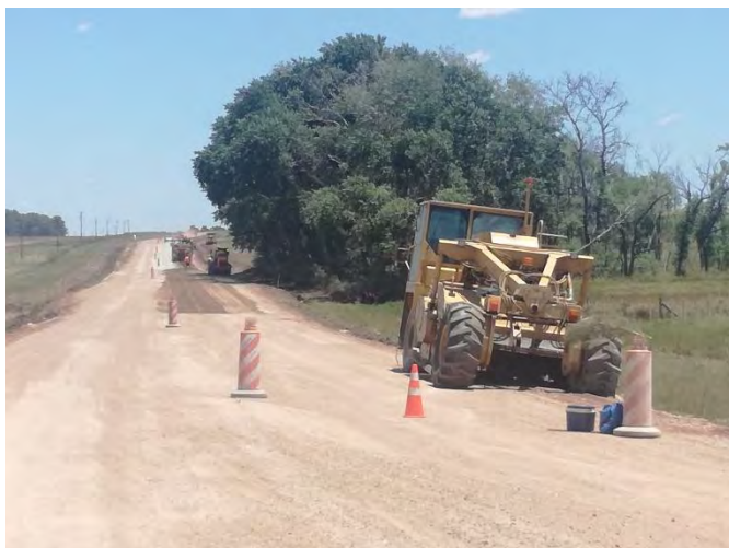
Foto 13.27-1 Vta.12 Frente de Obra Díaz Álvarez
