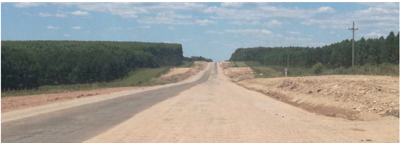
Foto 13.30-1 Vta.15 Tramo en obra - FRIVAL
