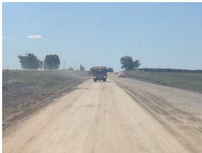
Foto 13.31-1 Vta.18 Frente de Obra CVC
