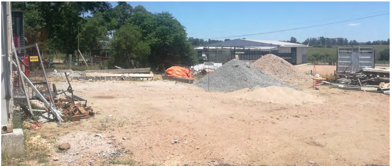
Foto 13.26-1 Vtas. Obrador FRIVAL
