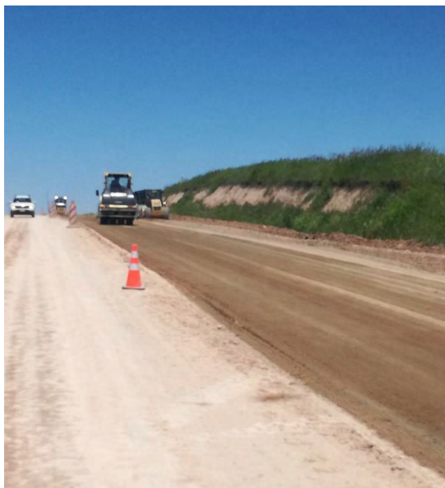
Foto 13.15-2 Vta.3 Frente de Obra CUJÓ
