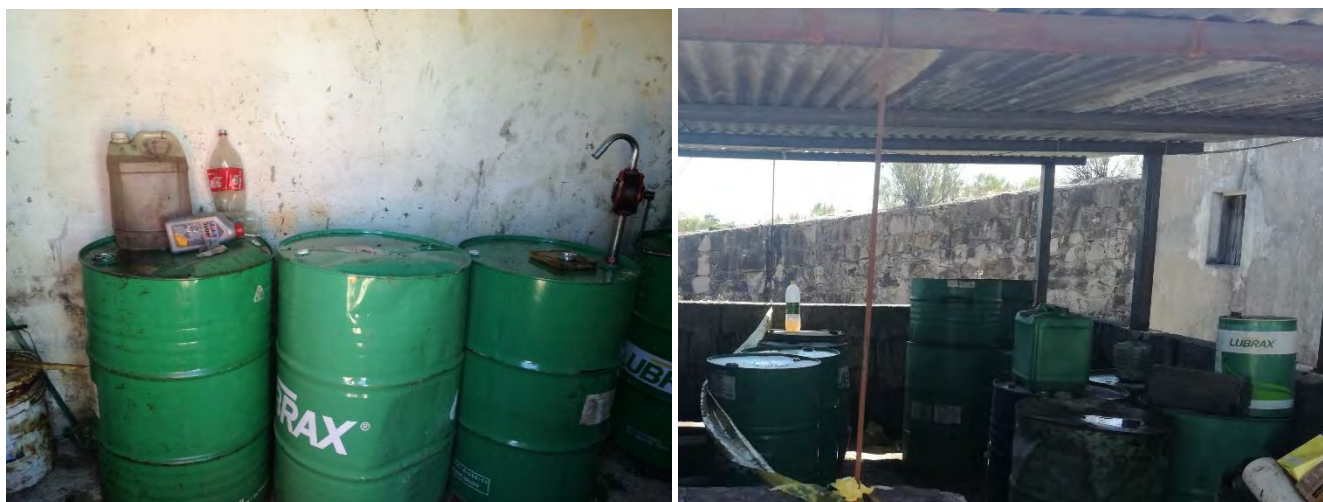
Foto 13.2-1 Obs.2 Envase con etiqueta original conteniendo hidrocarburos en Obrador Díaz Álvarez
