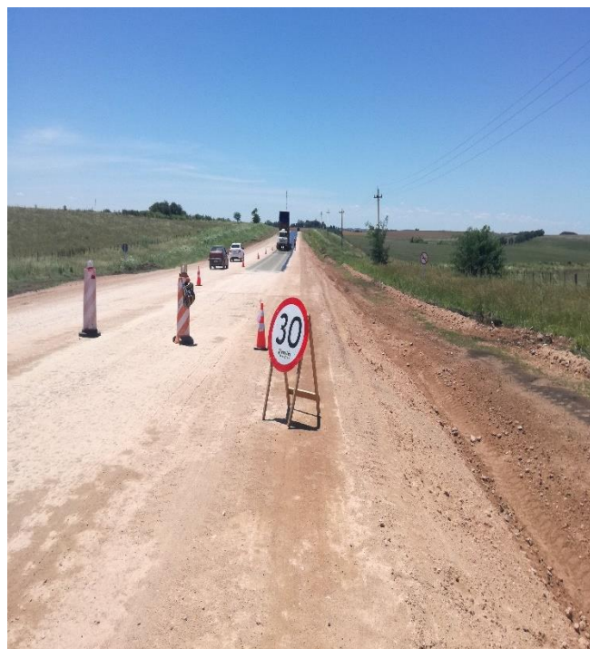
Foto 13.15-1 Vta.4 Frente de Obra CUJÓ
