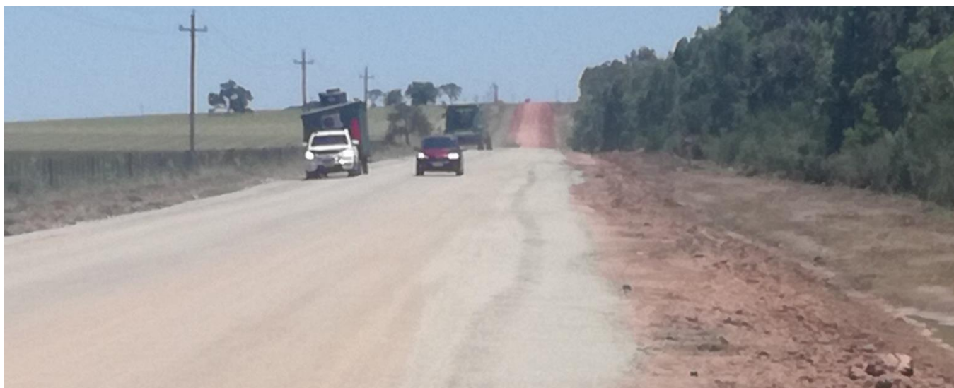
Foto 13.18-2 Vta.8 Frente de Obra CUJÓ
