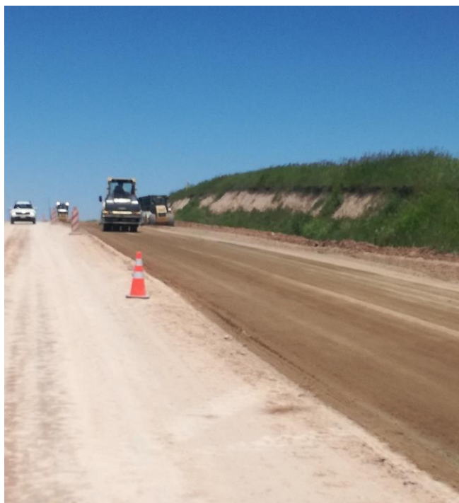
Foto 13.15-2 Vta.3 Frente de Obra CUJÓ
