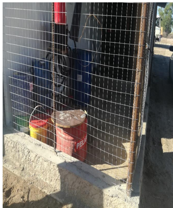
Foto 13.35-1 Vtas. Obrador ESPINA
