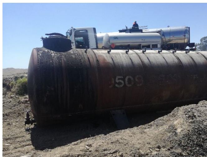
Foto 13.5-1 NC 3 - Tanques de asfalto sin dique de contención obrador Días Álvarez
