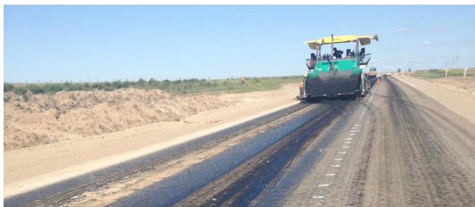
Foto 13.31-3 Vta.19 Frente de Obra CVC
