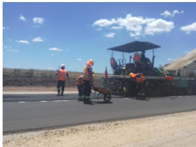
Foto 13.27-2 Vta.13 Frente de Obra Díaz Álvarez
