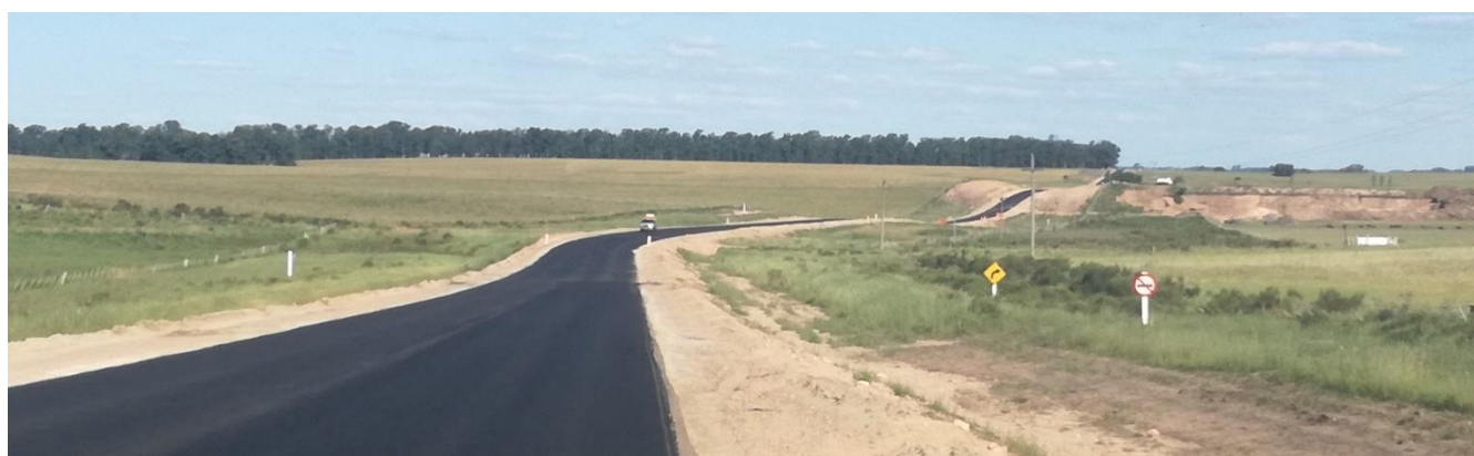
Foto 13.34-1 Vta.20 Tramo Terminado CVC
