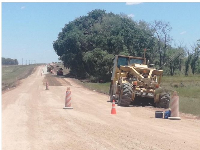
Foto 13.27-1 Vta.12 Frente de Obra Díaz Álvarez
