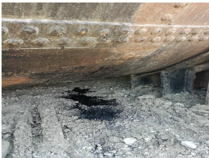
Foto 13.5-1 NC 3 - Tanques de asfalto sin dique de contención obrador Días Álvarez
