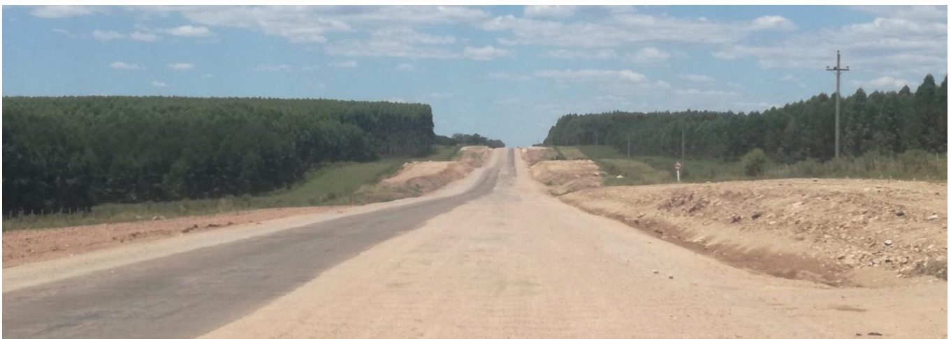
Foto 13.30-1 Vta.15 Tramo en obra - FRIVAL
