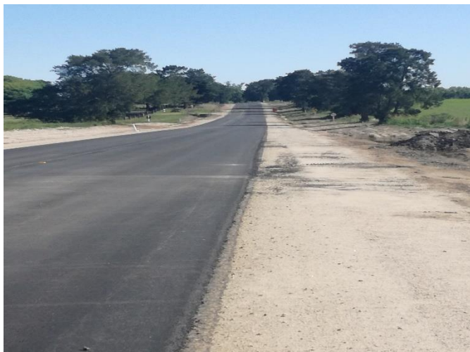
Foto 13.22-1 Vta.10 Tratamiento bituminoso INCOCI
