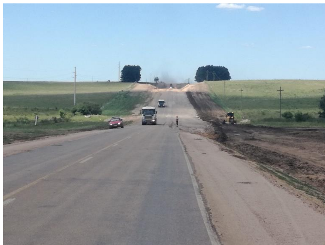
Foto 13.31-2 Vta.17 Frente de Obra CVC
