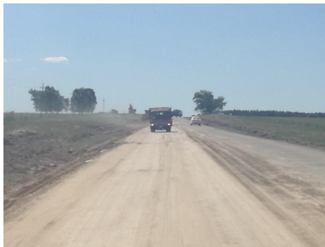
Foto 13.31-1 Vta.18 Frente de Obra CVC
