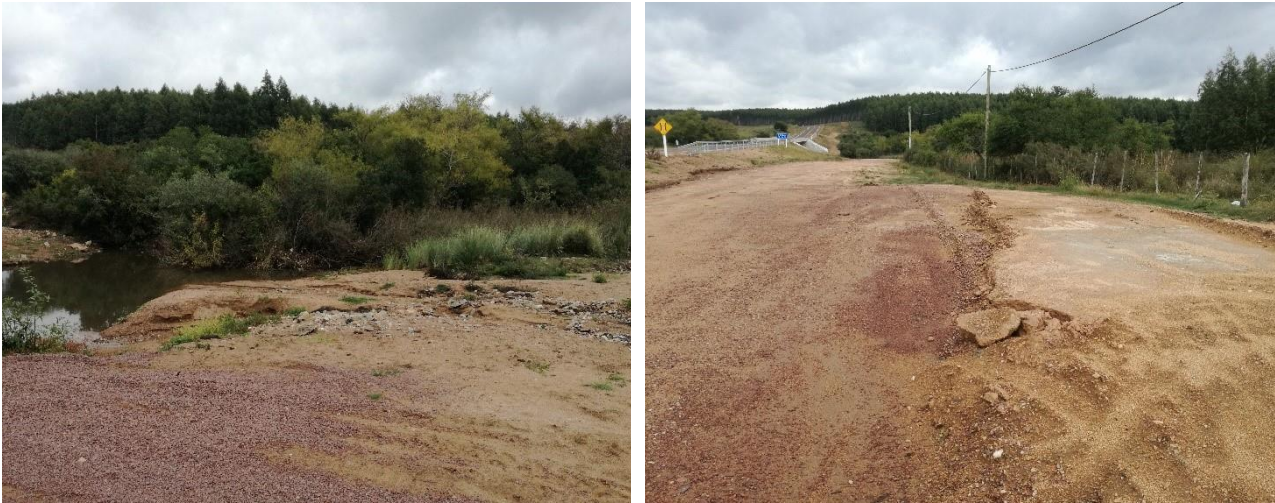
Foto 13.1-1 Puente Arroyo El Potrero - Ruta 7
