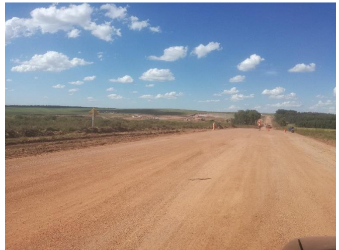
Foto 13.9-3 Frente de obra
