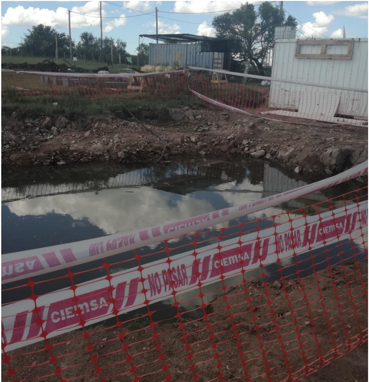
Foto 13.4-1 Fosa con agua estancada en mal estado.
