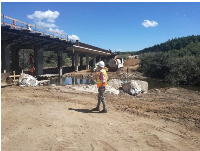
Foto 13.9-1 Obra Pte. Ao. El Potrero
