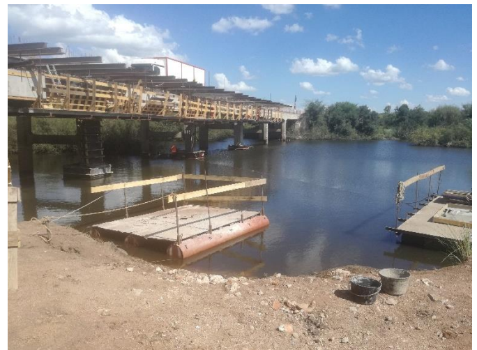
Foto 13.9-2 Obra Pte. Ao. Mansavillagra
