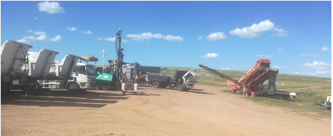
Foto 13.7-1 Vista Equipos en Obrador MELITER
