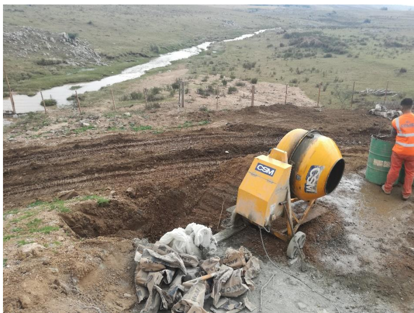
Foto 13.2-1 Frente de Obra - Alcantarilla
