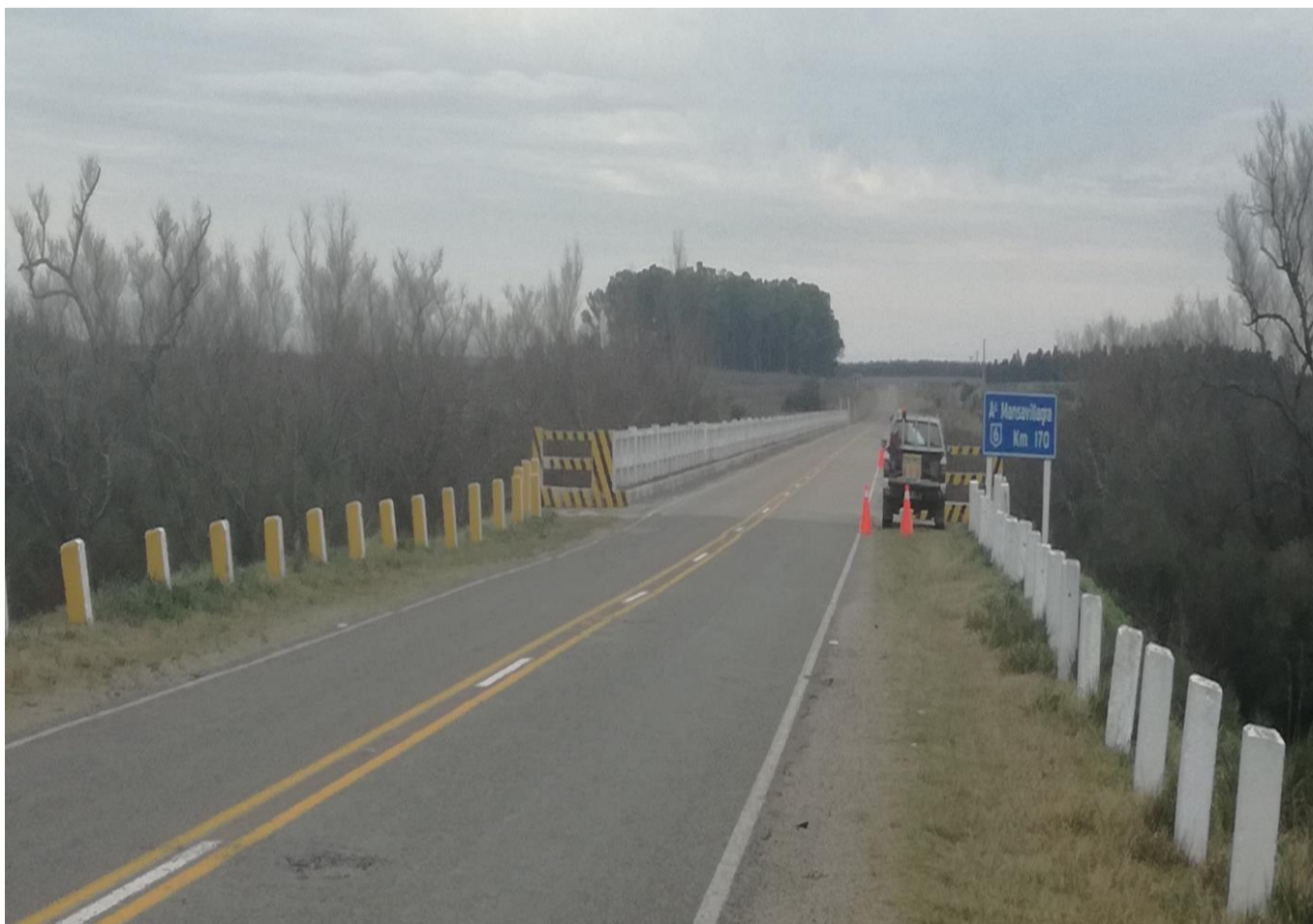
Foto 13-2 Tareas de recuperación Pte. Ao. Mansavillagra – Ruta 6
