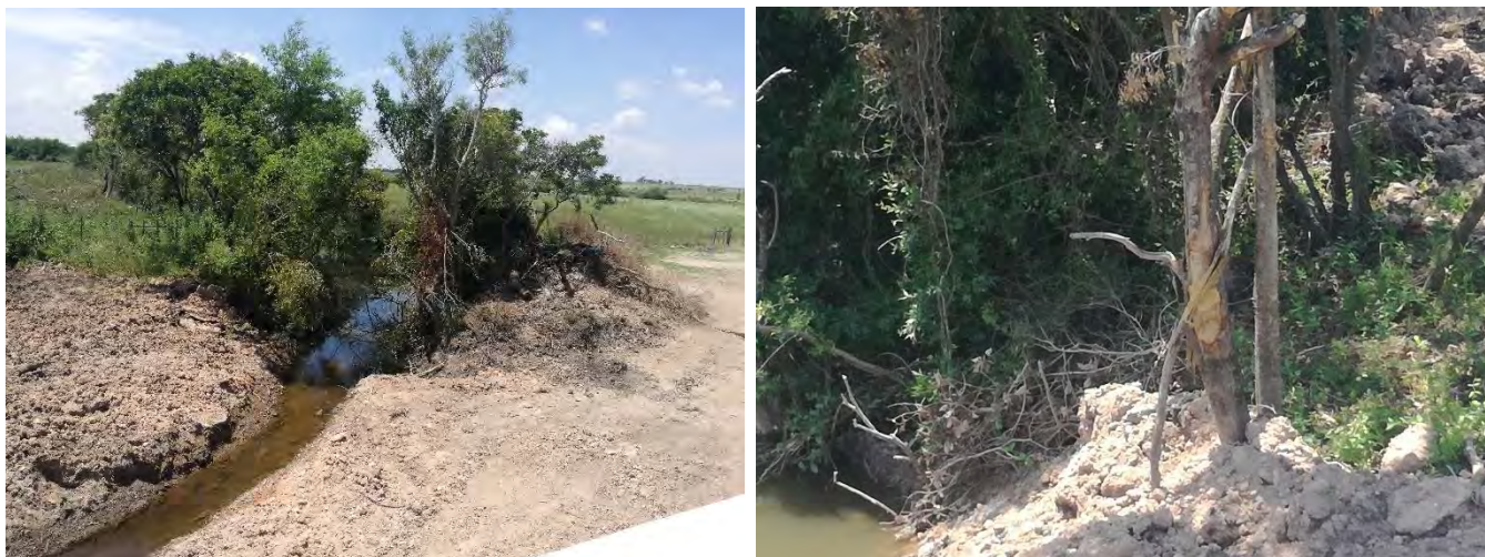
Foto 13.6-1 Vegetación dañada en Pte. Ao. Sauce
