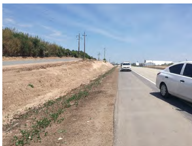
Foto 13.9-2 Vta.2 Senda Peatonal
