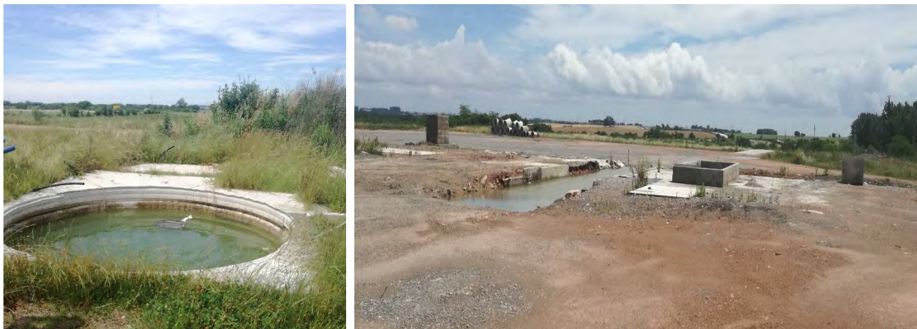
Foto 13.4-1 Estructuras con agua estancada en Obrador Ruta 24
