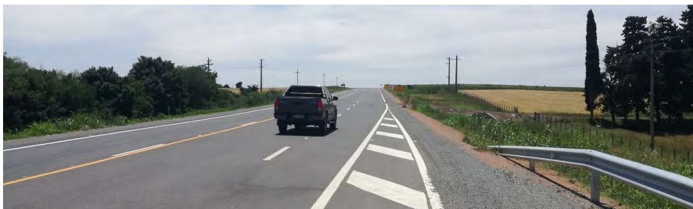
Foto 13.15-1 Vta.4 Ruta 21 Tramo terminado
