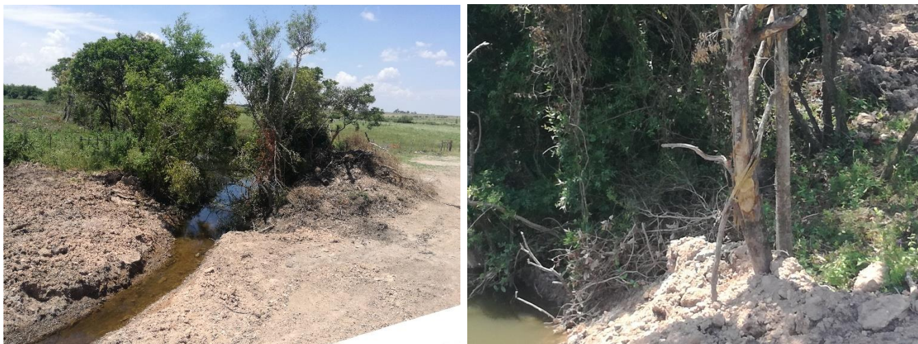
Foto 13.6-1 Vegetación dañada en Pte. Ao. Sauce
