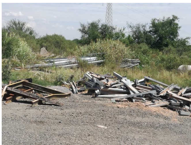
Foto 13.13-1 Vistas Planta asfáltica Dolores en etapa de PRA
