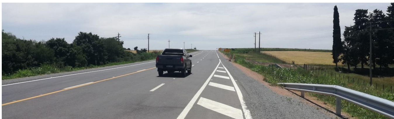
Foto 13.15-1 Vta.4 Ruta 21 Tramo terminado
