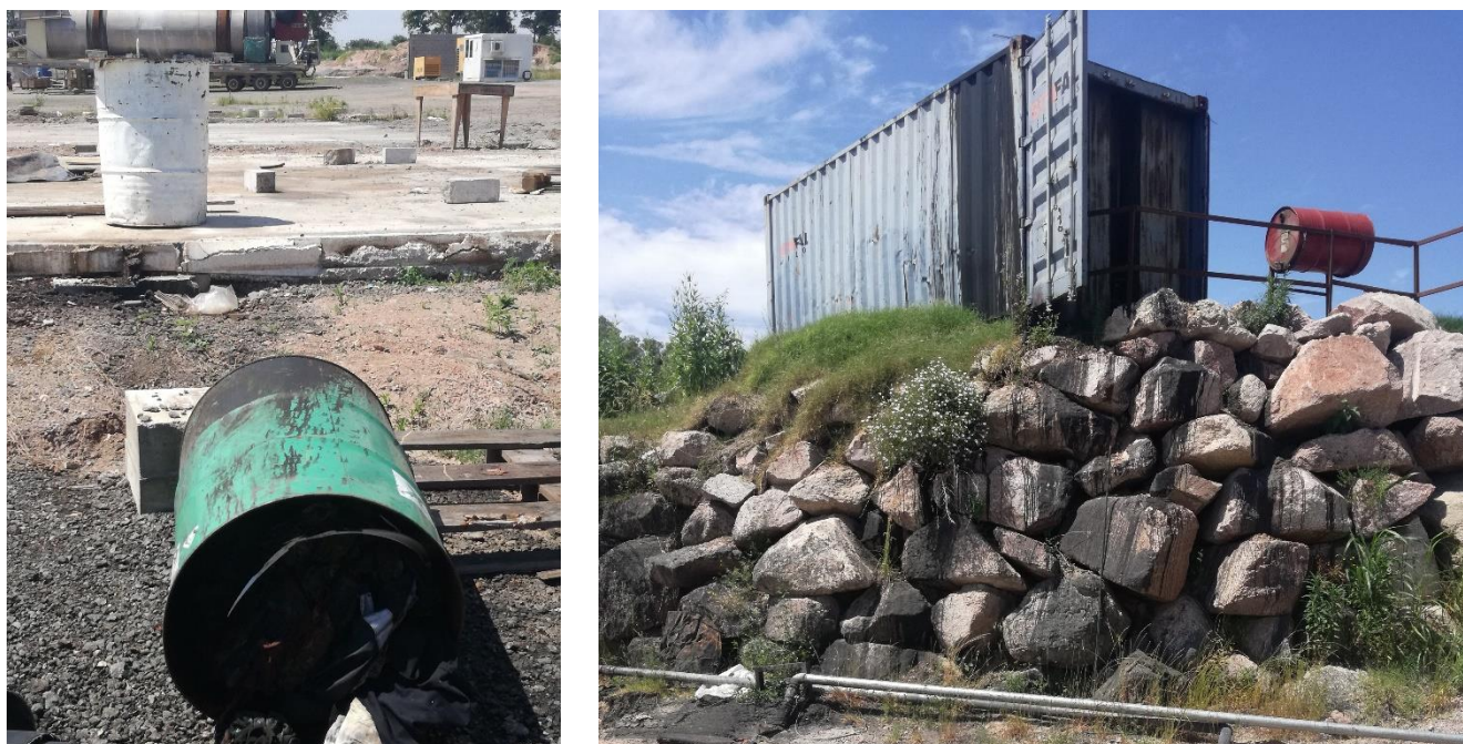
Foto 13.7-1 Residuos especiales y derrames en Planta asfáltica Dolores en etapa de PRA
