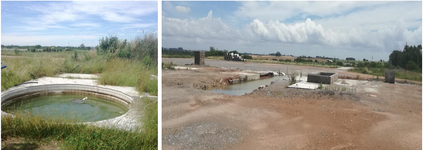
Foto 13.4-1 Estructuras con agua estancada en Obrador Ruta 24
