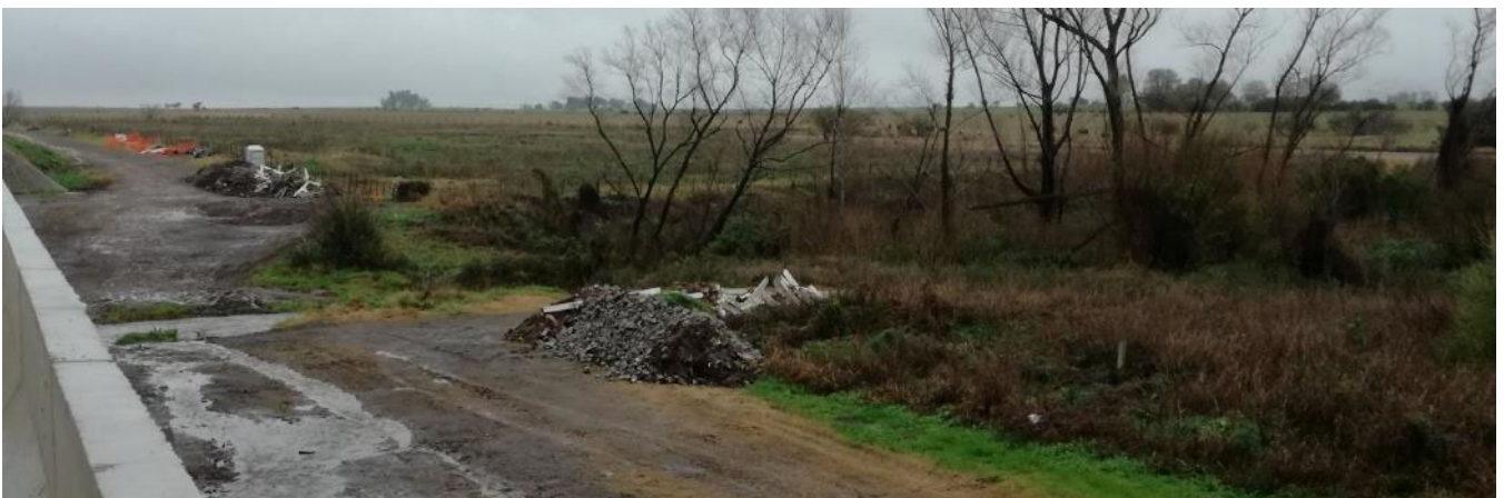
Foto 13.3-2 Puente Arroyo Bizcocho, residuos en área inundable
