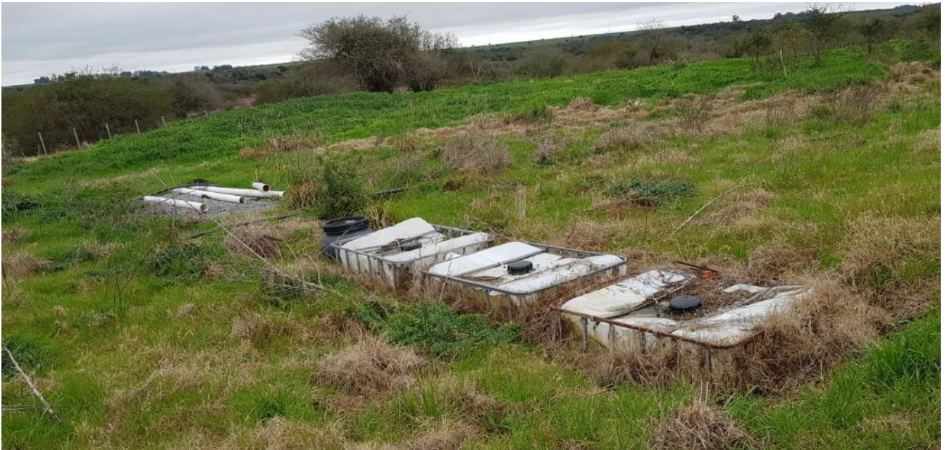
Foto 13.1-2 Restos de estructuras en Obrador Ruta 24
