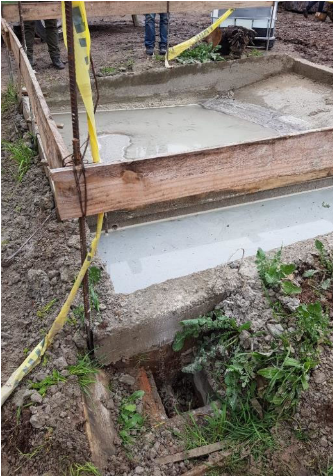
Foto 13.5-1 Puente Arroyo Negro_ derrame lavado de hormigón
