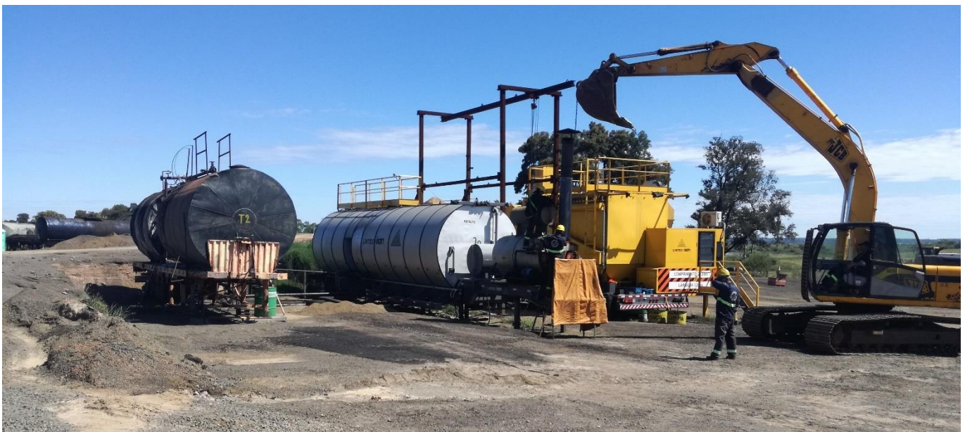
Foto 13.2-1 Planta de Asfalto
