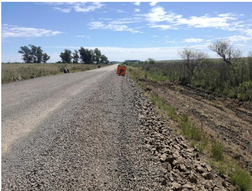
Foto 0-1 Ramal de Ruta 30, Ruta 3 – Tomas Gomensoro
