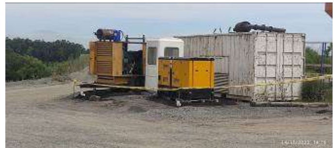
Foto 12.3-1 Diques de contención inadecuados.
