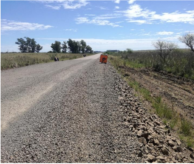
Foto 9 Vista de tramo de obra
