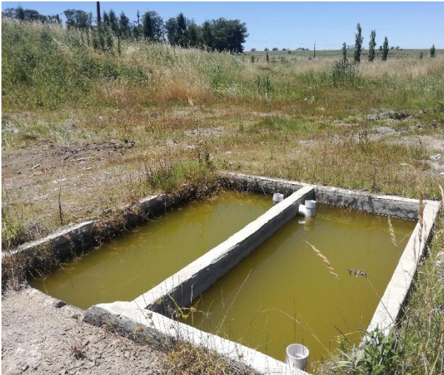
Foto 19 No Conformidad. Estructura en desuso con agua estancada.
