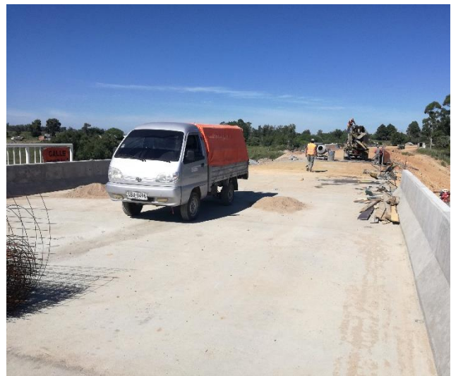
Foto 8 Vista frente de obra.
