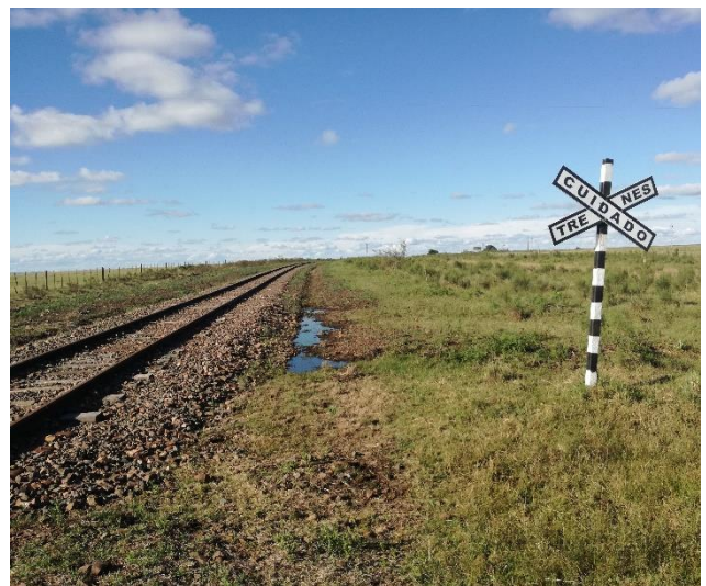
Foto 4 Tramo de vía.
