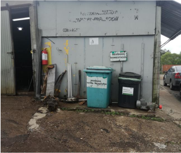
Foto 17 Instalaciones para recolección de RR.SS.
