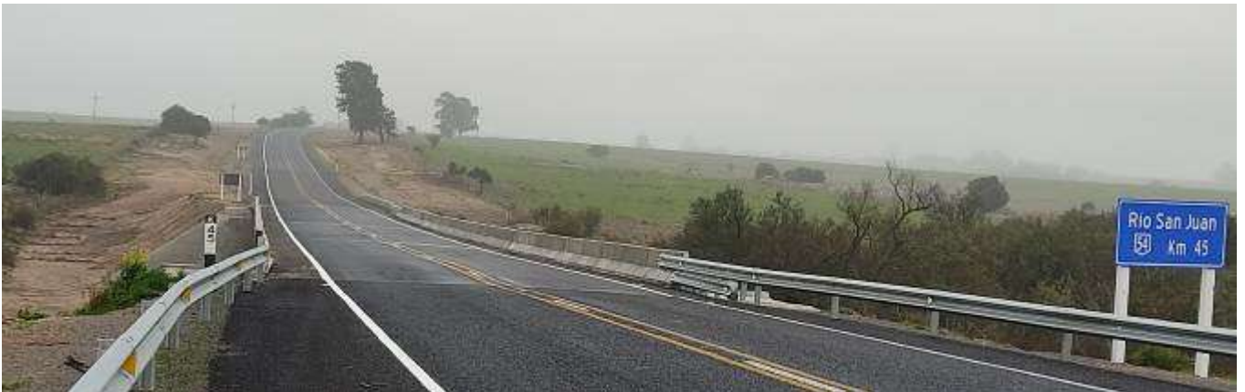
Foto 13.2-1 Erosiones en torno al Puente Ruta 54 - Río San Juan
