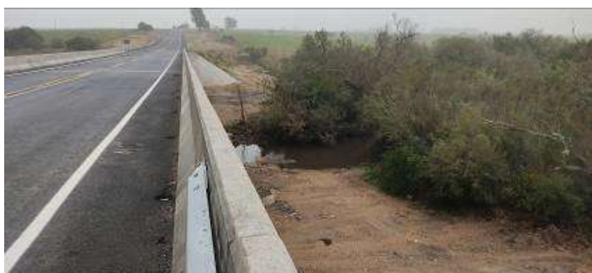
Foto 13.6-1 Puente Río San Juan
