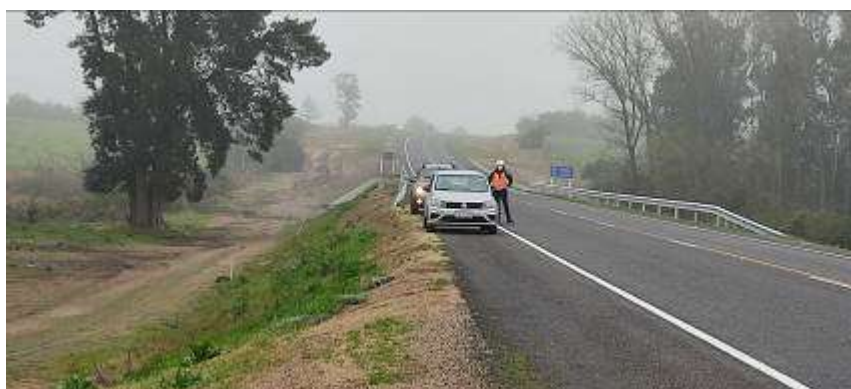
Foto 13.4-1 Puente Arroyo Miguelete
