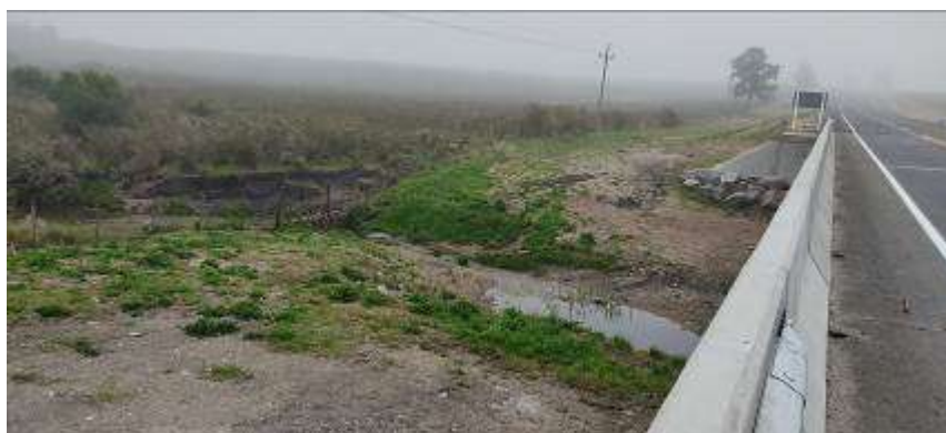
Foto 13.5-1 Puente Arroyo Sauce
