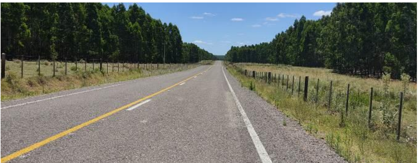
Foto 13.3-1 Vistas del tramo terminado
