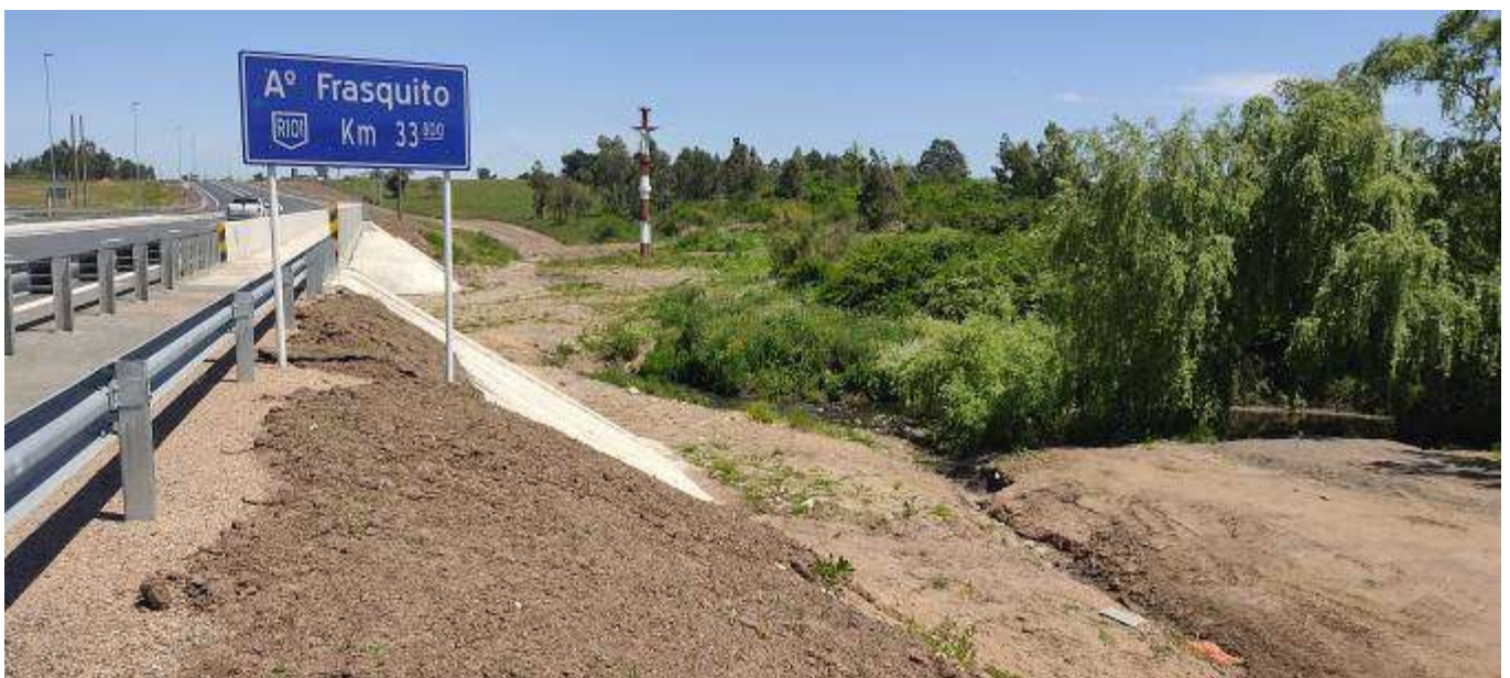
Foto 13.2-1 Vistas Puente Arroyo Frasquito
