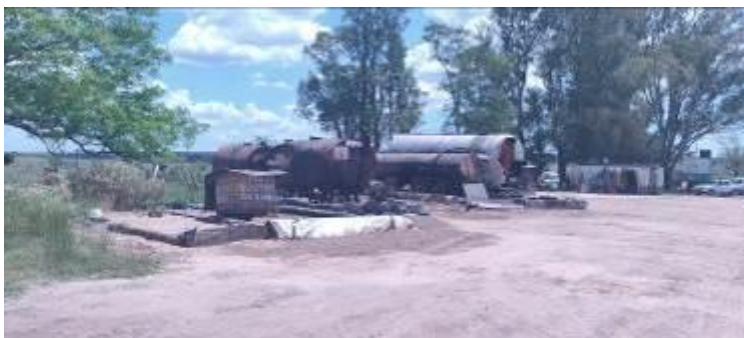
Foto 13.3-1 Vistas del Obrador
