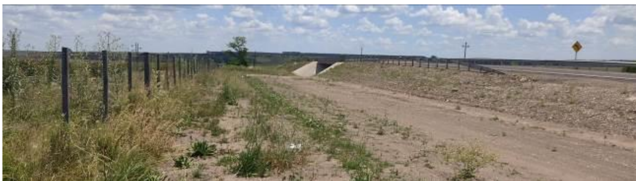
Foto 13.4-3 Pasaje Superior Vía Férrea
