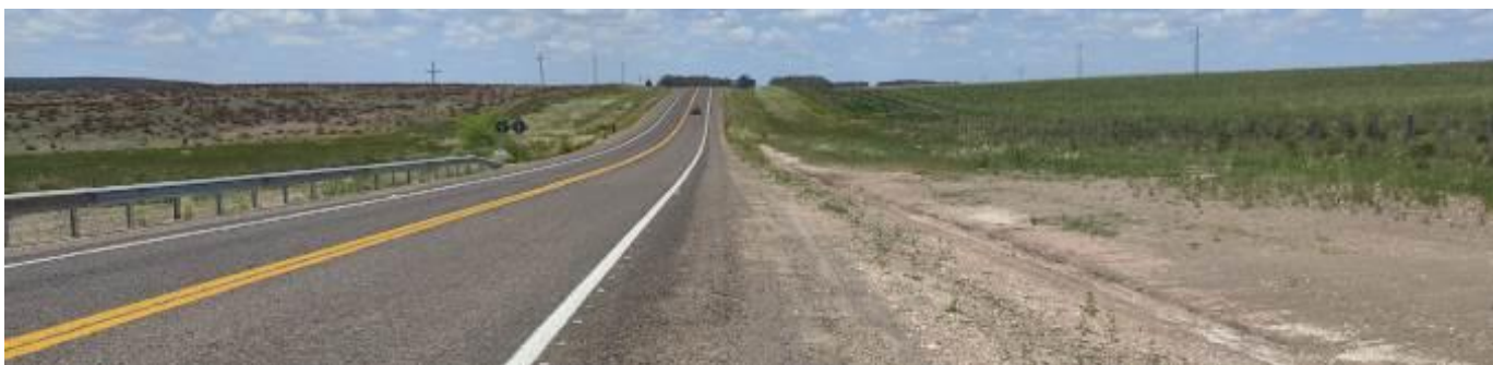
Foto 13.4-1 Vistas del tramo terminado
