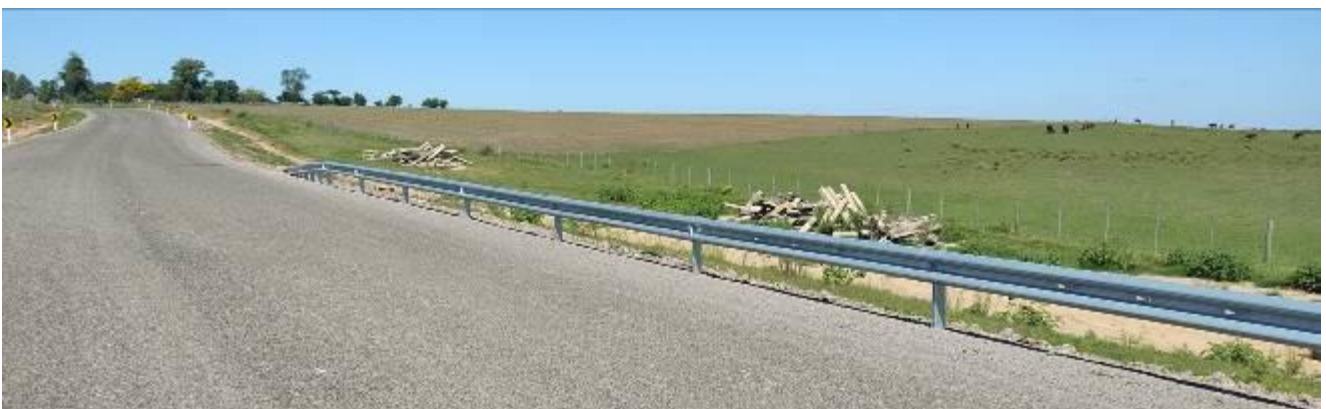
Foto 13.1-2 Vista 1 - Acopios en espera de traslado para su disposición final.
