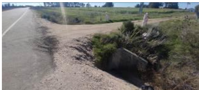
Foto 13.1-2 Erosión en tramo PR24.
