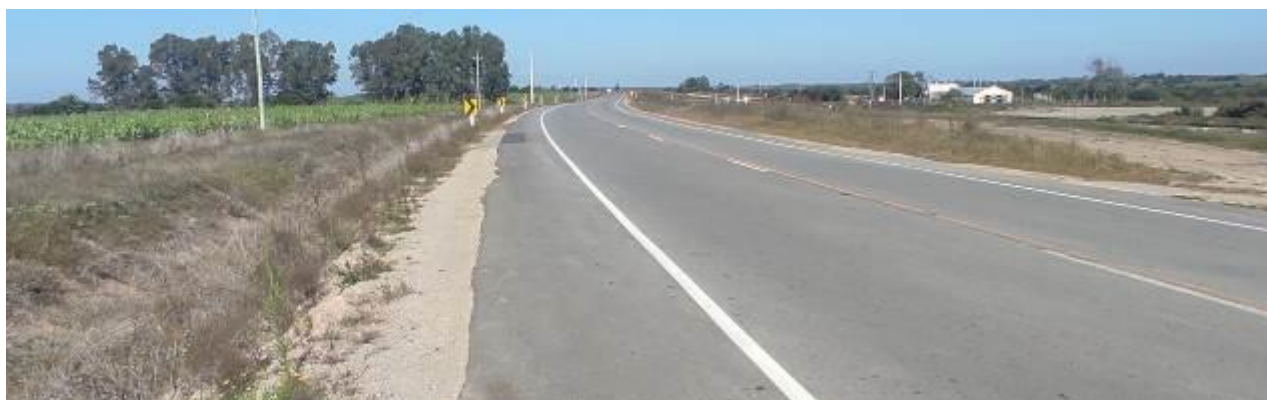
Foto 13.3-1 Vistas del tramo PR24
