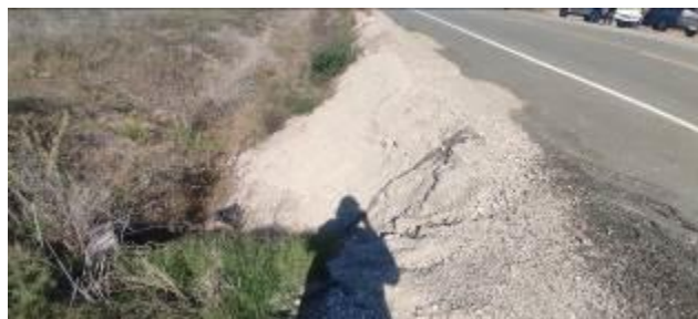
Foto 13.1-2 Erosión en tramo PR24.
