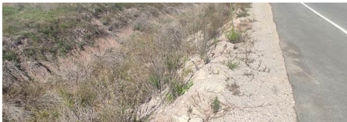
Foto 13.1-1 Erosión en tramo PR33.
