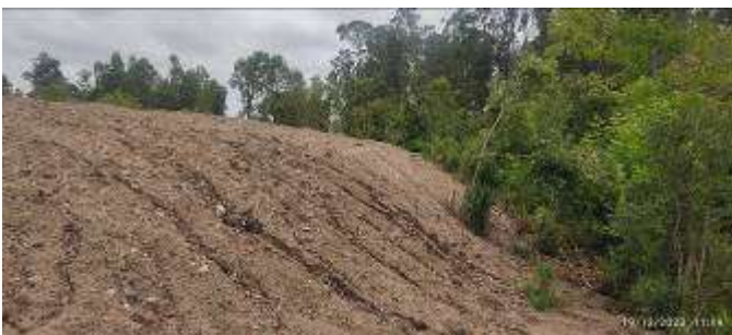
Foto 12.2-2 Erosiones en Puente Arroyo Las Conchas
