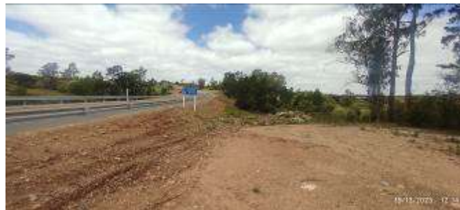
Foto 12.5-1 Vistas Puente Arroyo Casimiro.
