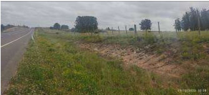
Foto 12.2-1 Erosiones en Bypass Rocha.
