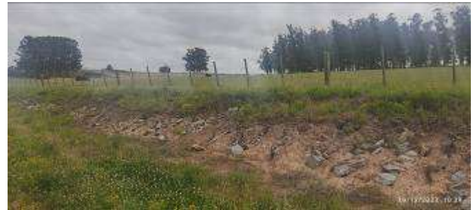
Foto 12.2-1 Erosiones en Bypass Rocha.
