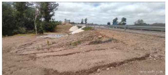
Foto 12.2-2 Erosiones en Puente Arroyo Las Conchas
