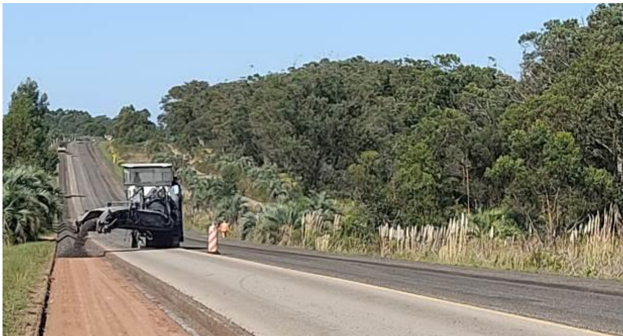
Foto 13.16-1 Recargo de RAP en banquetas.
