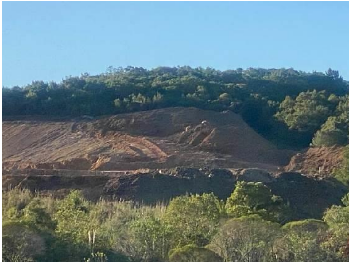
Foto 13.19-1 Vistas Cantera y Obrador
