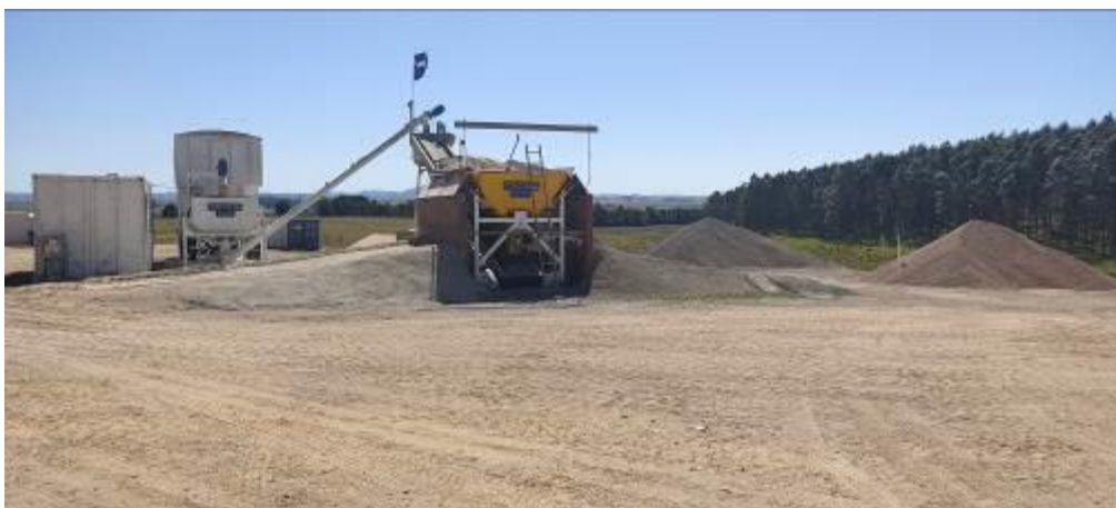
Foto 13.8-1 Vistas Planta de Asfalto
