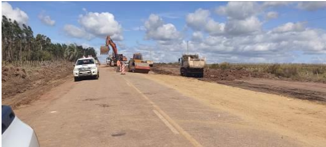
Foto 13.22-1 Vistas tramo en obra Ruta 15.
