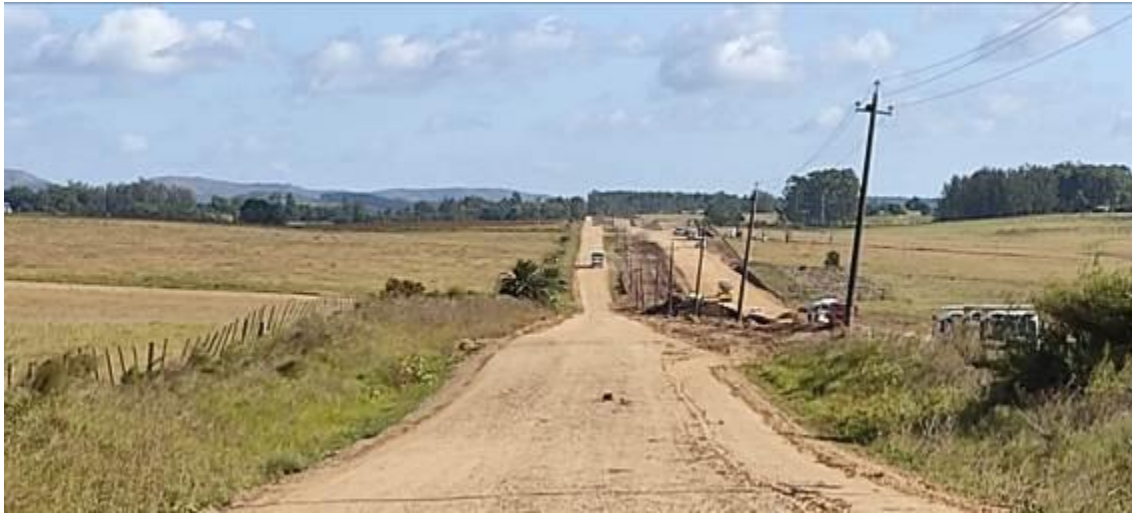
Foto 13.17-1 Vistas obras Bypass
