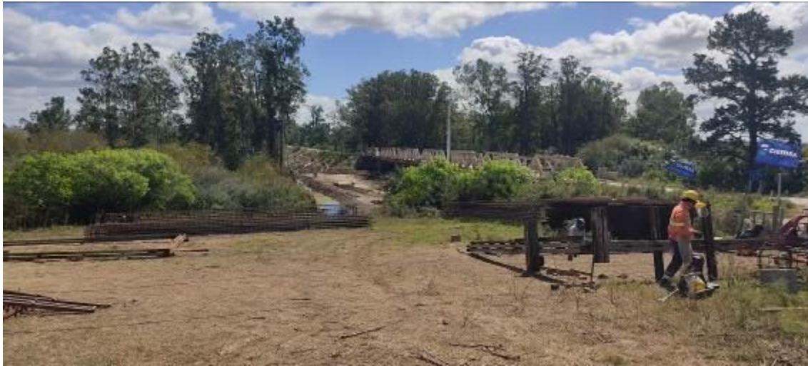
Foto 13.21-1 Vistas puente y campamento
