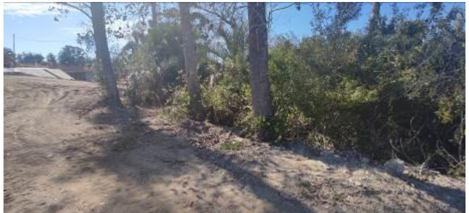
Foto 13.1-2 NC1- Puente Arroyo Las Conchas
