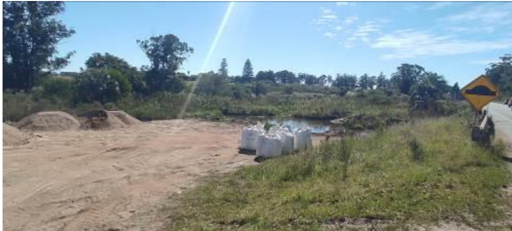
Foto 13.2-2 NC2-Puente Arroyo Las Conchas 2
