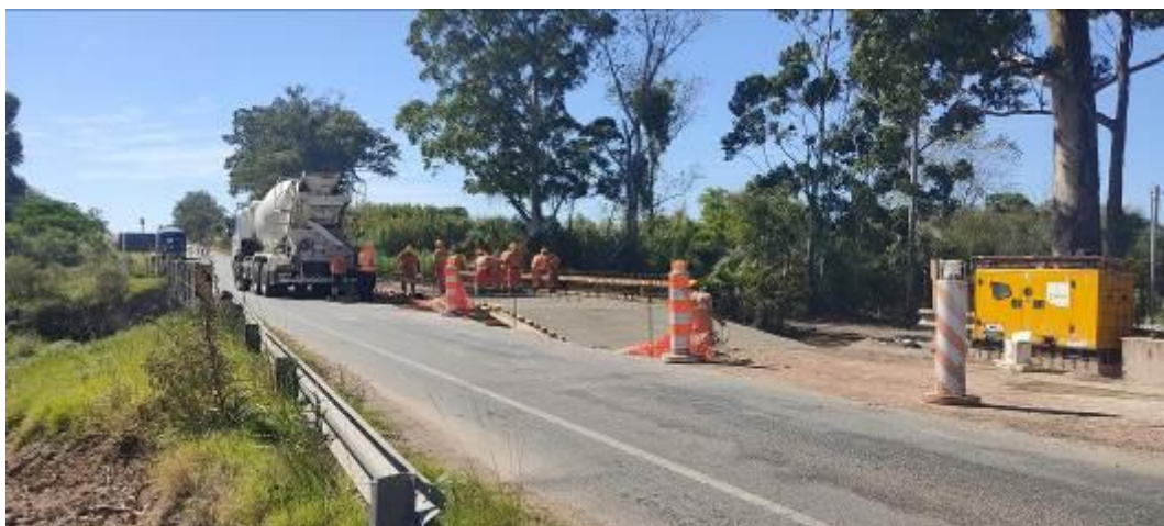
Foto 13.6-1 Vistas Puente Arroyo Las Conchas 2
