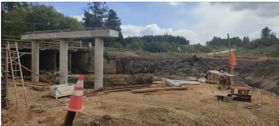
Foto 13.20-1 Vistas Puente en obra
