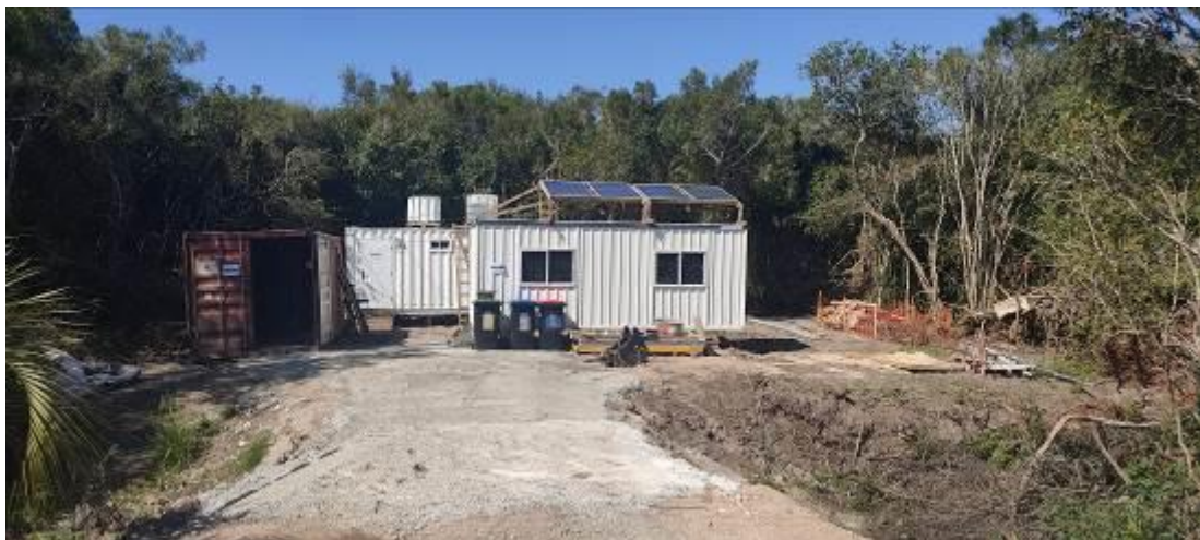
Foto 13.9-1 Vistas Puente y campamento
