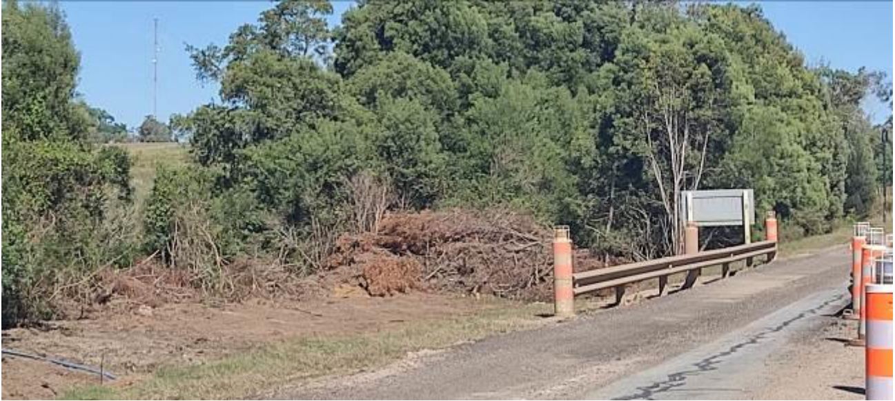
Foto 13.1-4 NC1 – Puente Cañada Zanja Honda.
