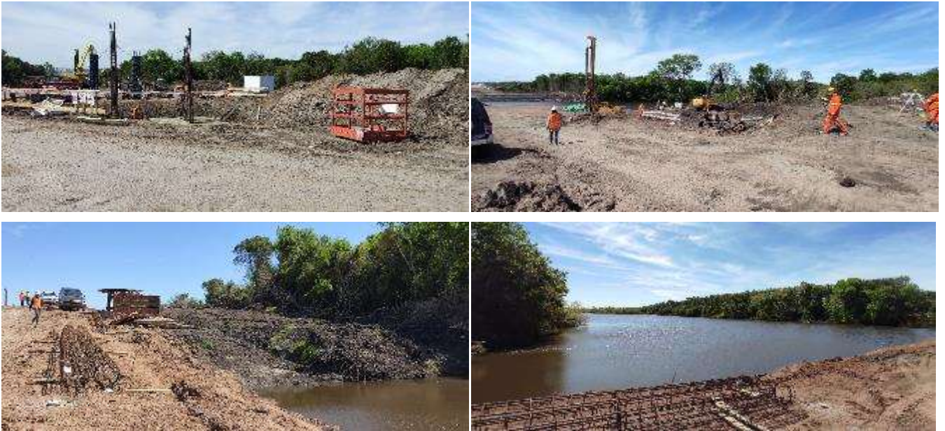
Foto 13.5-1 Vistas Frente de Obra Pte. San José
