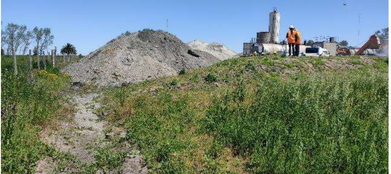
Foto 13.3-3 Riesgo de arrastre de materiales a terrenos vecinos.
