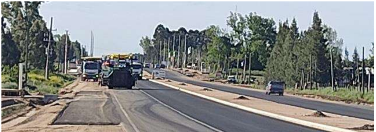
Foto 13.7-1 Recorrido por tramo en Obra de Ruta 3
