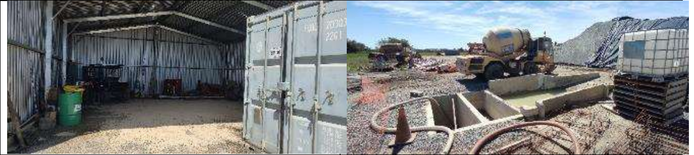
Foto 13.4-1 Vistas Obrador CVC
