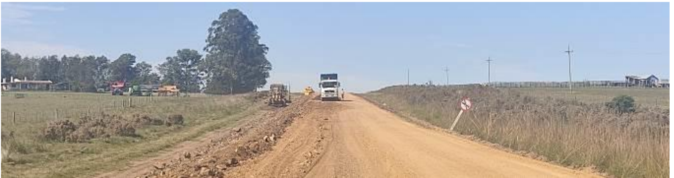
Foto 13.4-2 Frente de obra
