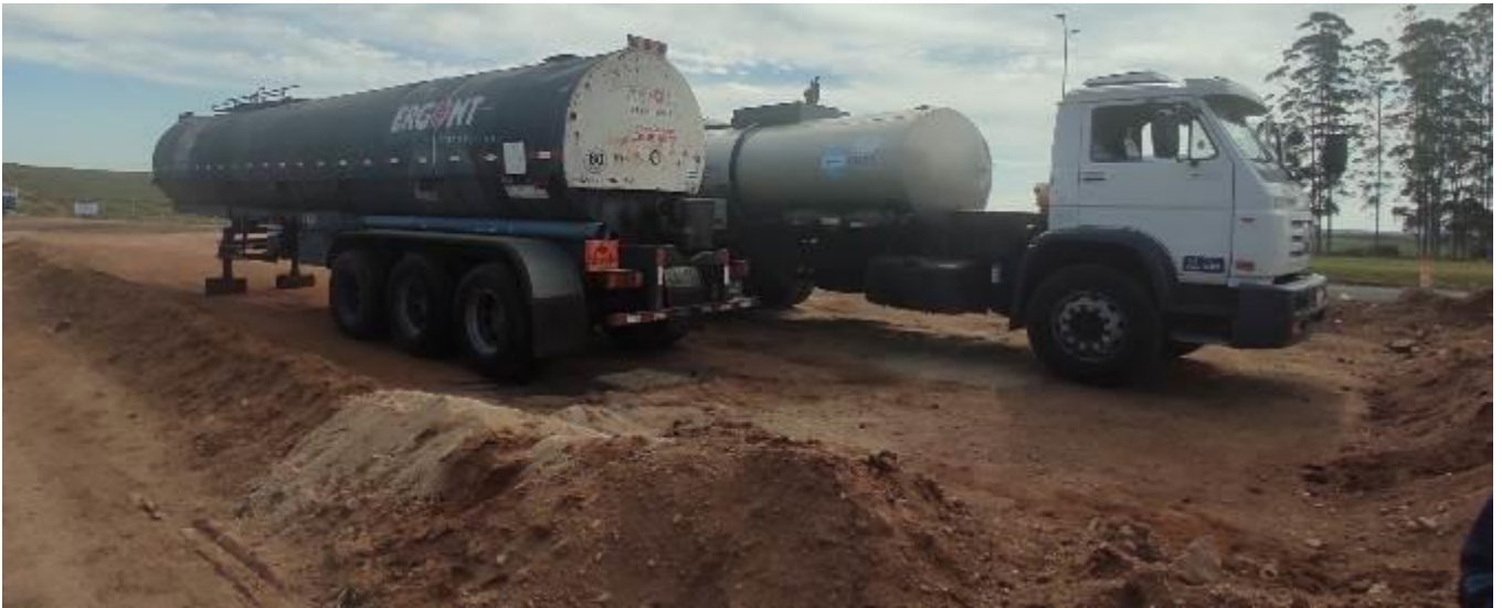
Foto 13.1-1 Dique sin condiciones de estanqueidad.
