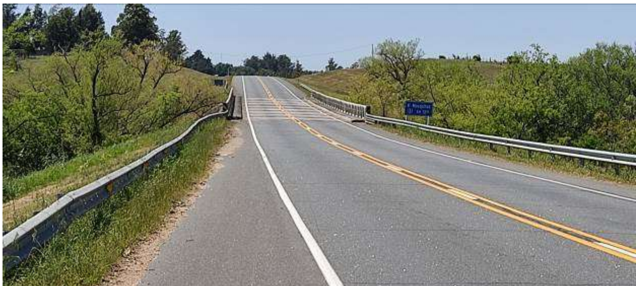
Foto 13.4-3 Entorno Puente Arroyo Mosquitos
