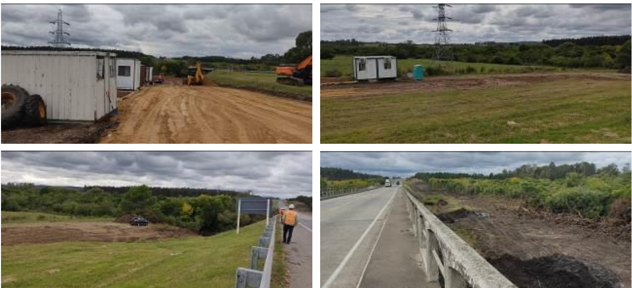
Foto 13.5-1 Vistas obrador y frente de obra
