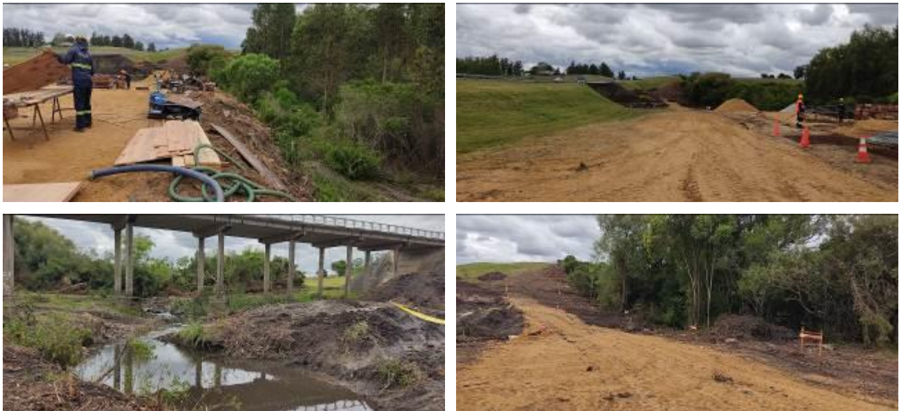
Foto 13.6-1 Vistas obrador y frente de obra.
