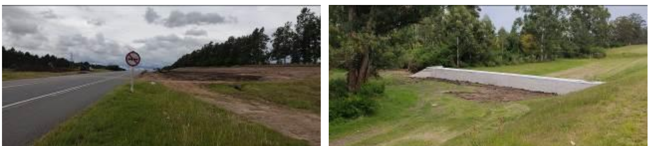
Foto 13.7-1 Vistas del tramo de Ruta 8 en obra
