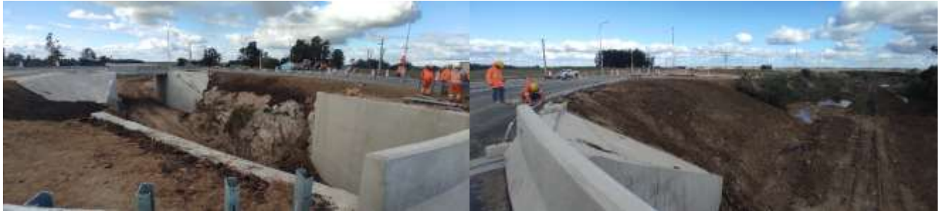
Foto 13.9-1 Pasaje Superior Vía Férrea
