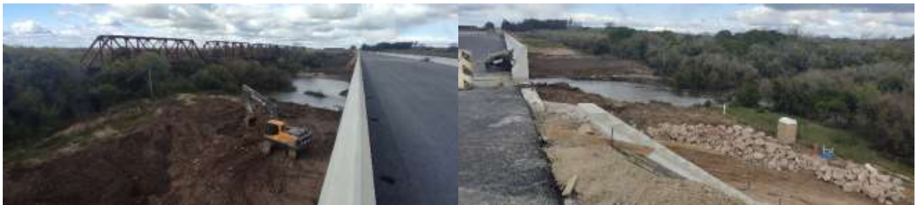
Foto 13.6-1 Puente Bypass - Río Yí
