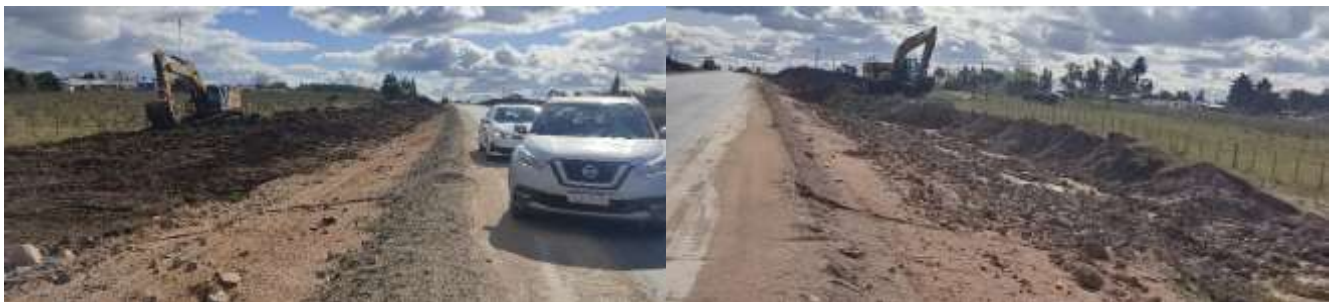
Foto 13.5-1 Recorrido por el tramo del Bypass Sarandí del Yí.
