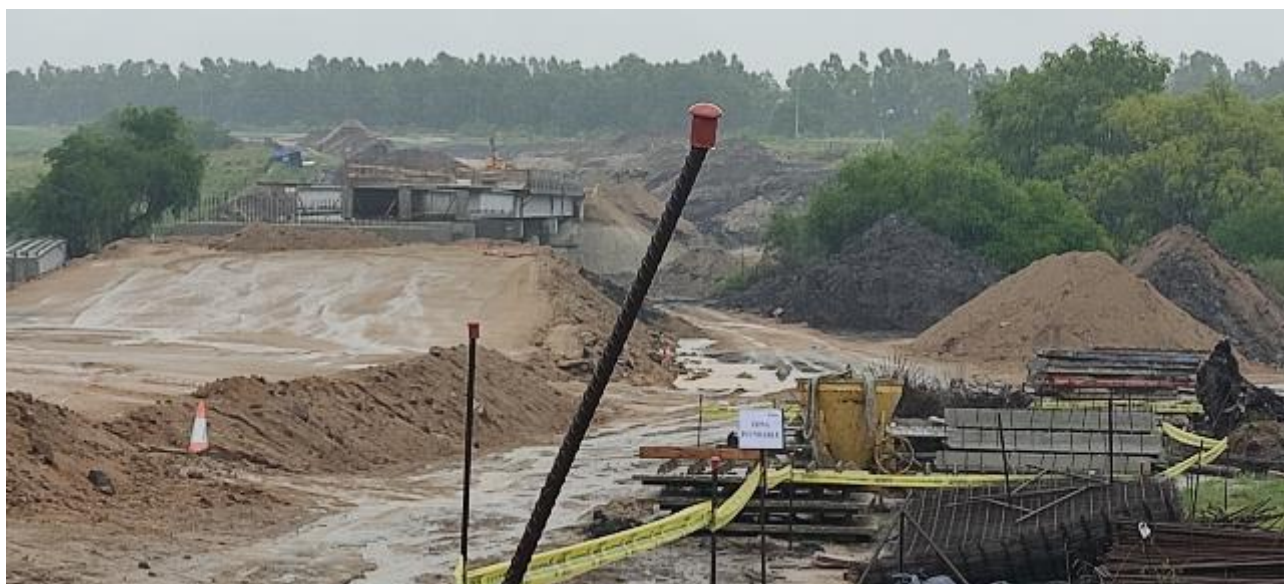
Foto 13.3-1 Vistas del entorno de la obra
