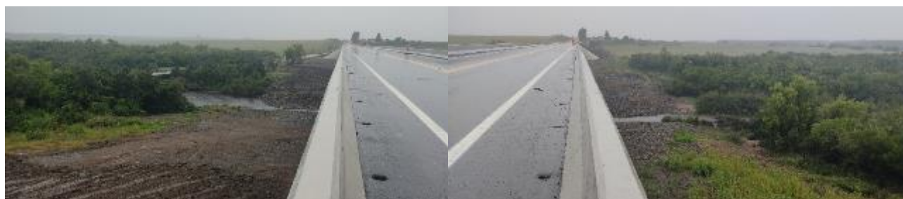
Foto 13.2-1 Vistas entorno de obra
