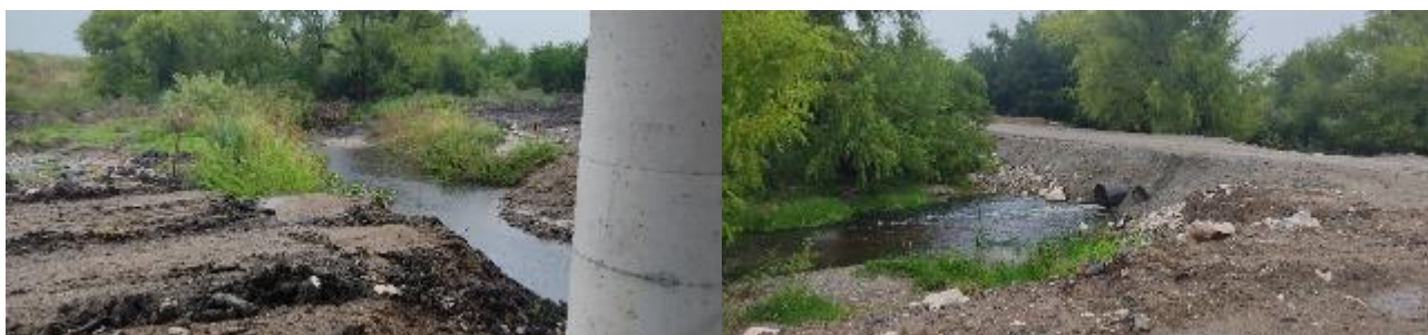
Foto 13.3-1 Vista entorno de obra Puente Arroyo Marincho
