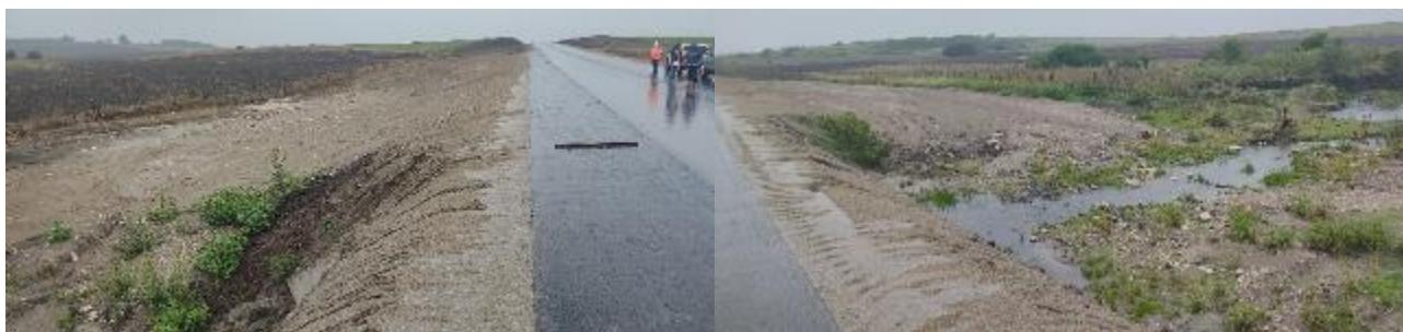
Foto 13.2-1 Entorno Puente Arroyo del Sauce
