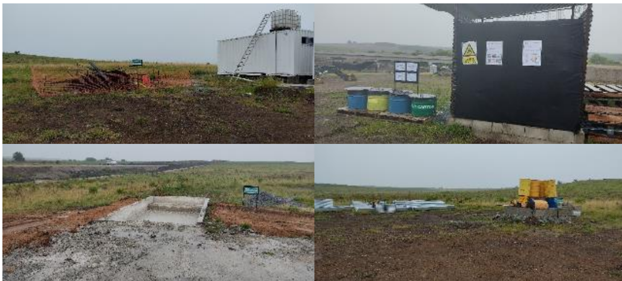
Foto 13.4-1 Vistas Obrador Espina
