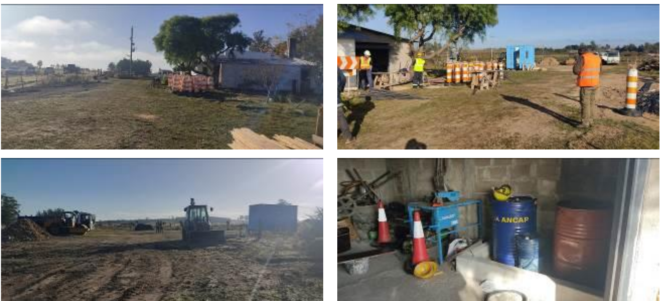
Foto 13.2-1 Vistas del Obrador
