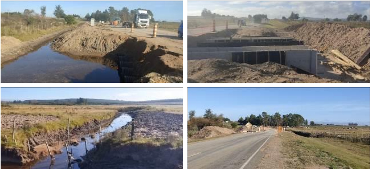
Foto 13.3-1 Vistas del Frente de Obra
