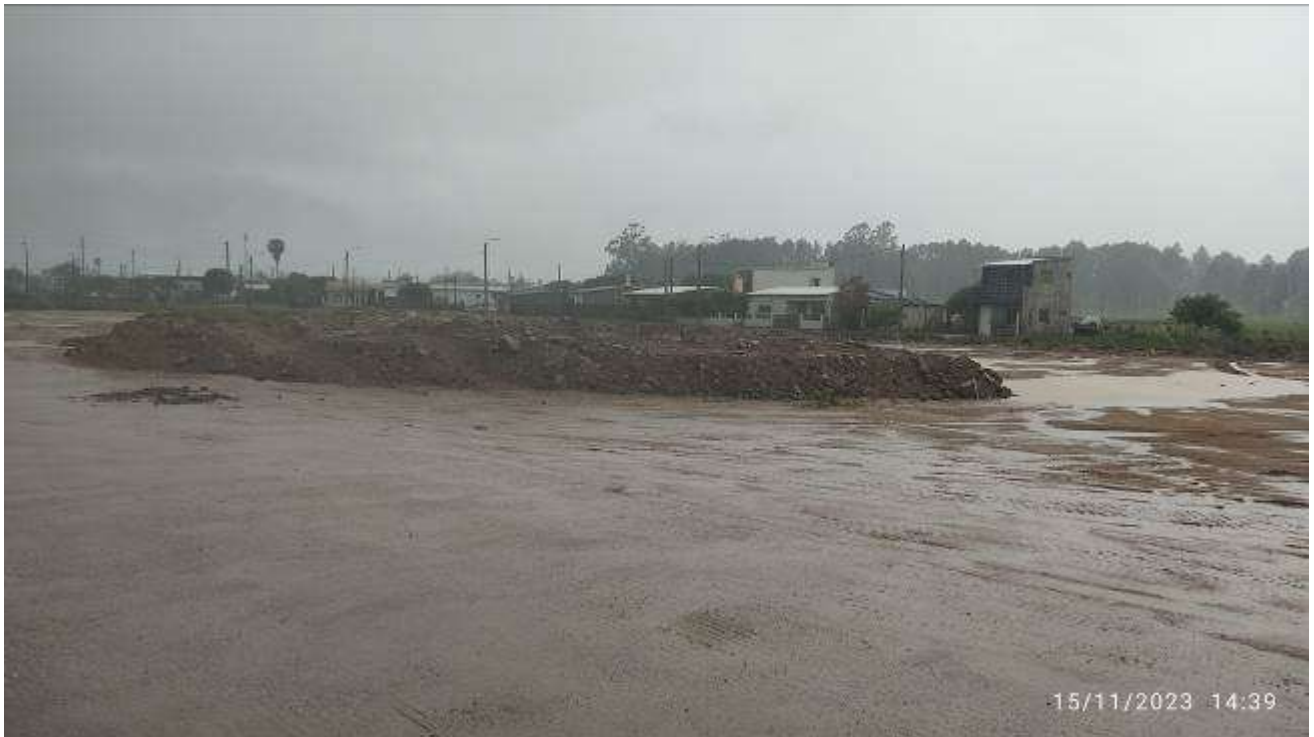
Foto 12.3-1 Vista del predio del Estacionamiento.
