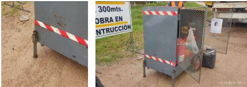
Foto 12.1-1 Depósito de hidrocarburos no estanco.
