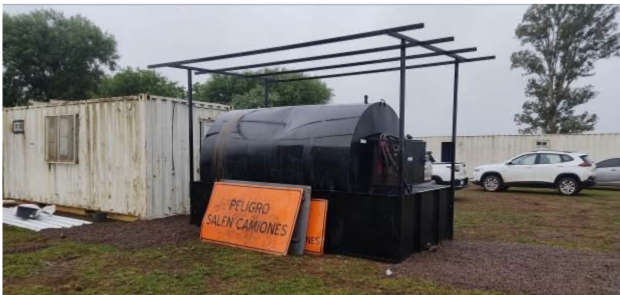
Foto 12.6-1 Obrador de Macromáquinas en etapa de instalación.
