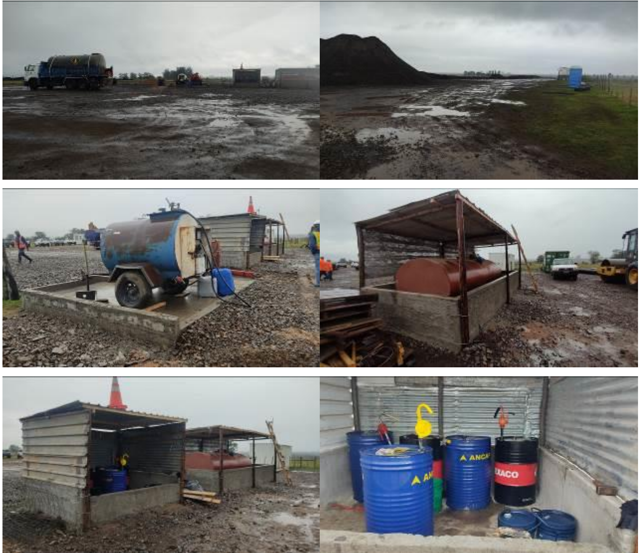
Foto 12.4-1 Vistas Obrador IMPACTO.
