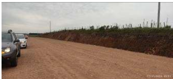
Foto 12.2-1 Taludes erosionados
