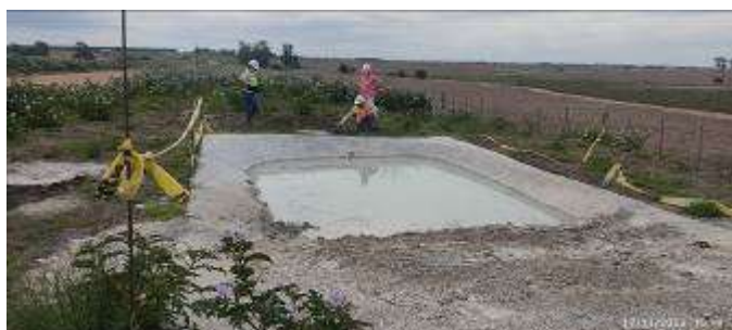
Foto 12.10-1 Piletas de lavado de hormigón.
