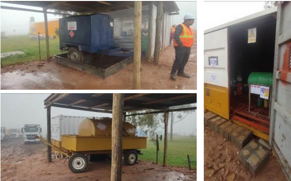
Foto 13.5-1 Obrador Subcontrato BISIO
