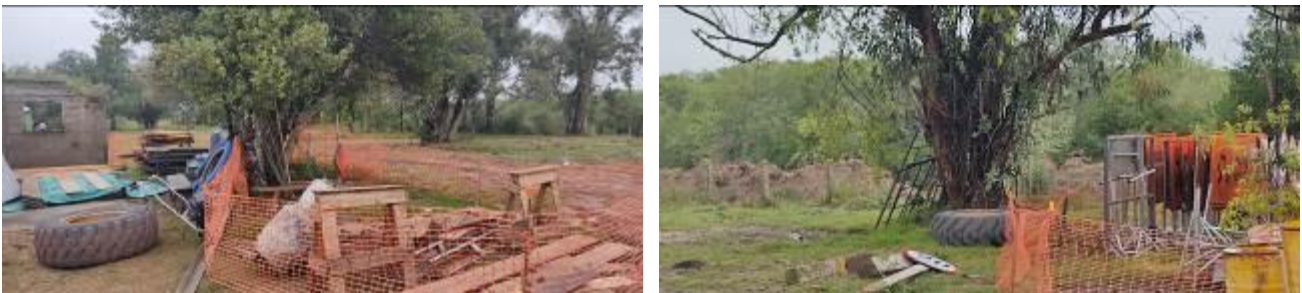
Foto 13.2-1 Estructuras apoyadas en vegetación existente.
