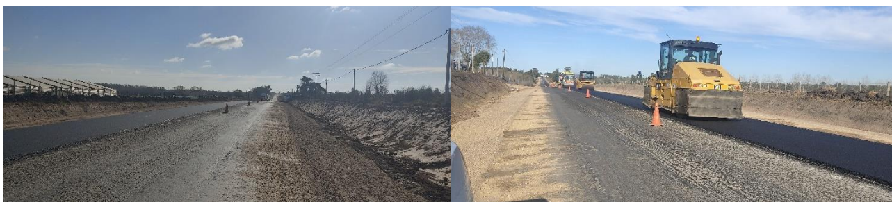
Foto 13.4-2 Vistas Frente de Obra en Tramo 612
