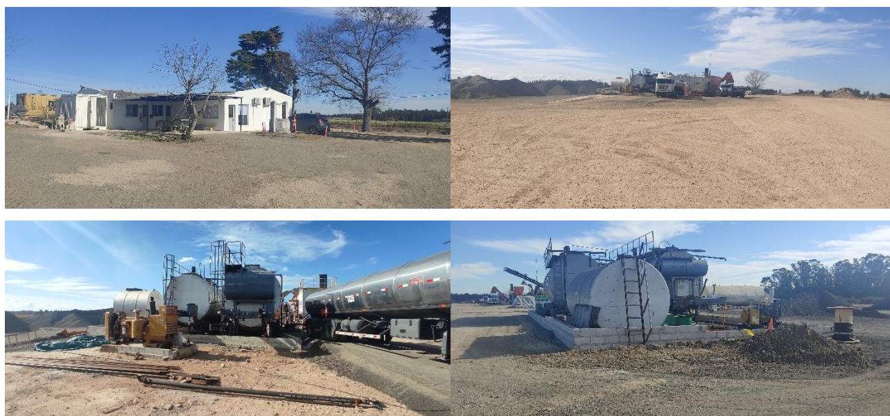
Foto 13.3-2 Vistas del Obrador de GCG
