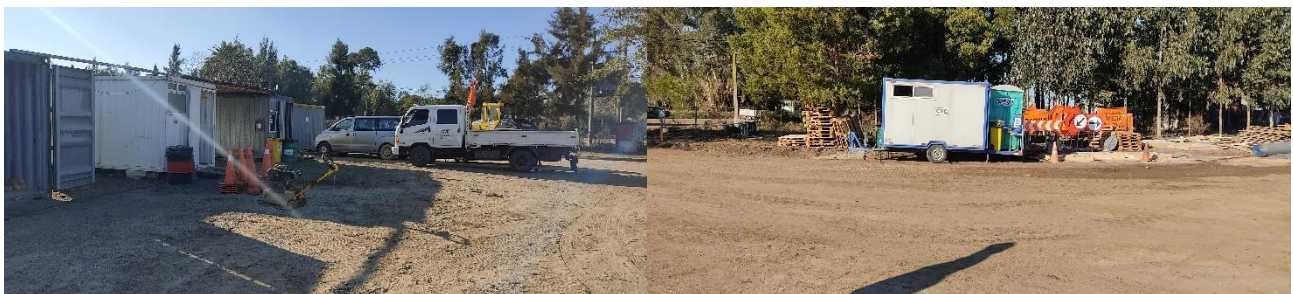
Foto 13.2-1 Vistas Obrador CVC 1
