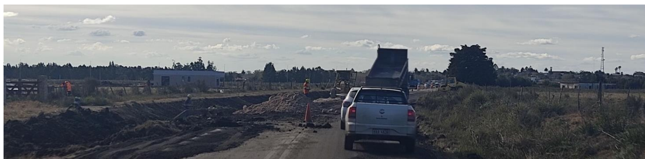
Foto 13.4-4 Vista Frente de Obra Tramo 614
